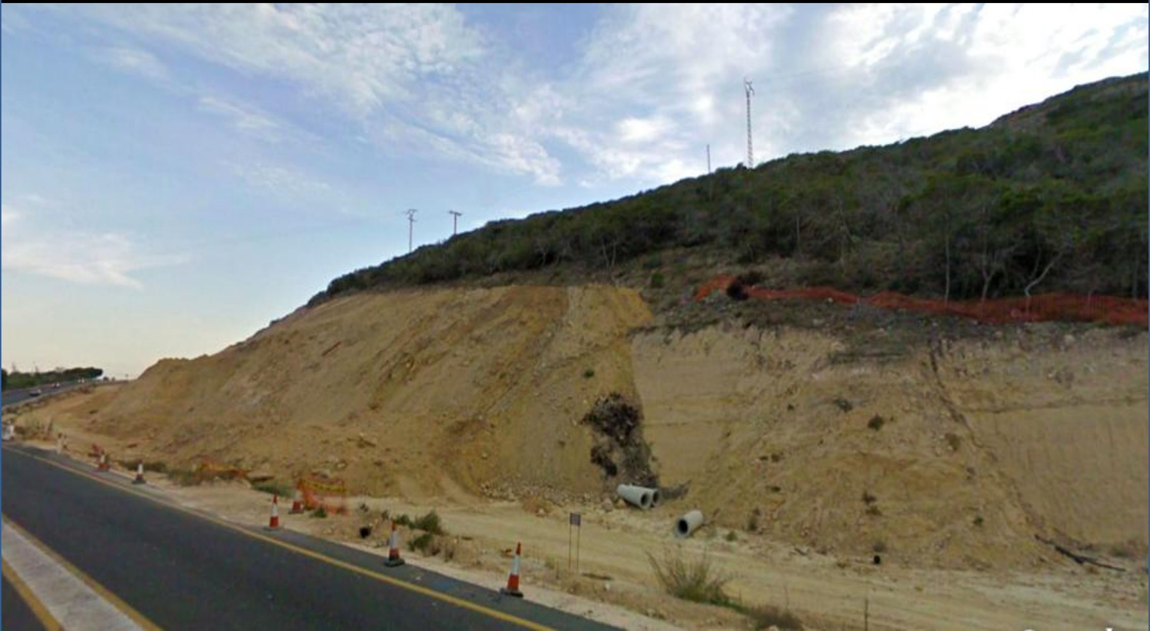
Areniscas y calcarenitas del Plioceno, Terciario. Fase de obras. En carretera Alicante -Cartagena. S de Guardamar, Alicante. Centro Hoja de Guardamar del Segura
