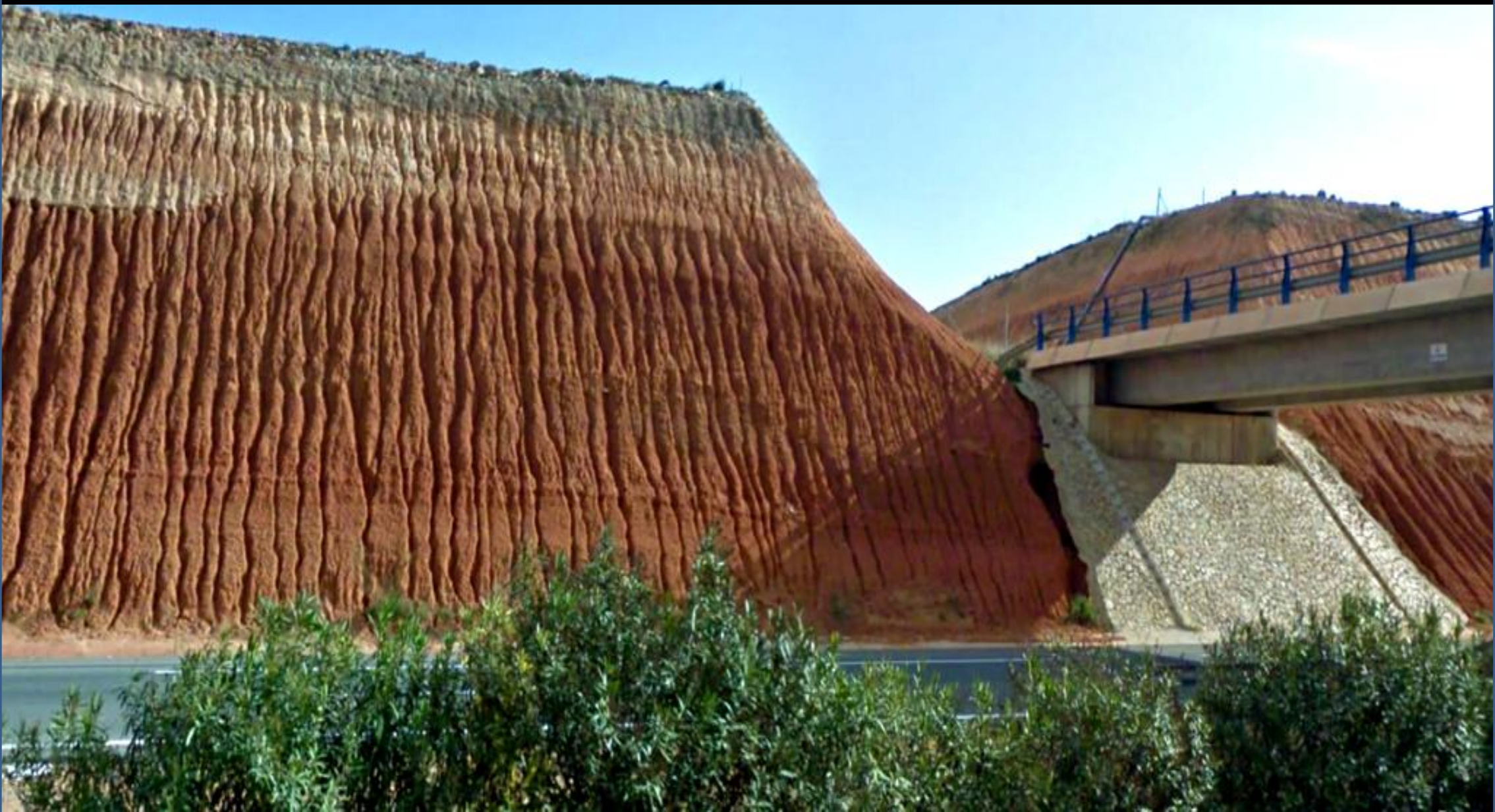
Talud acaravado de limos rojos- encima limos y arcillas Terciario-Cuaternario. Autopista Mediterráneo, Alicante. S Río Nacimiento, W de Cabo Roig. Centro Hoja de Torreveja.
