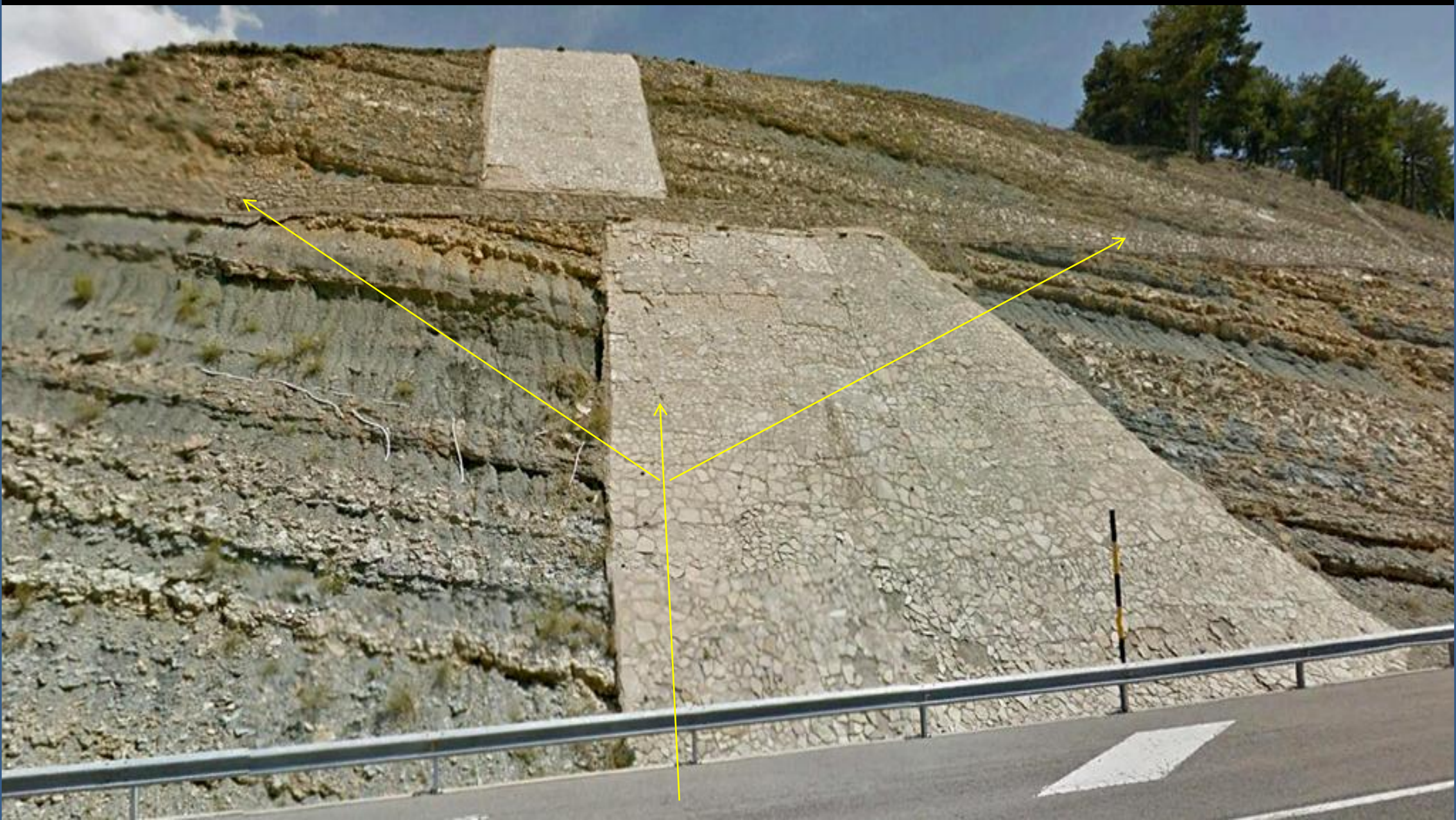
Detalle en la anterior: Intentos de estabilización de taludes de calizas y margas del Cretácico Inf. NE de Carrascal, Castellón. SW Hoja de Peñarroya de Tastavins.
