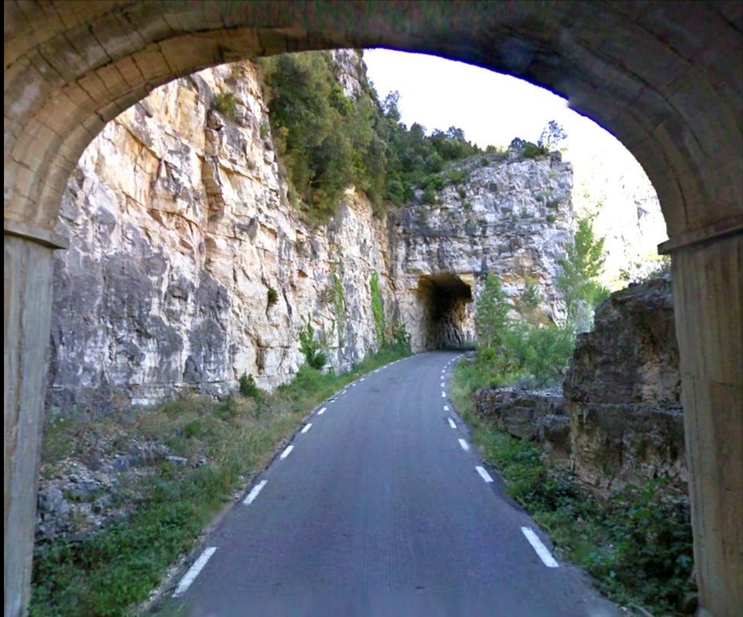
Túnel revestido y desde ese a otro sin revestir, en las calizas tableadas del tránsito Jurásico Sup. -Cretácico Inf. W de Cueva dels Rossegadors. E Embalse Ulldecona. SW Hoja Beceite
