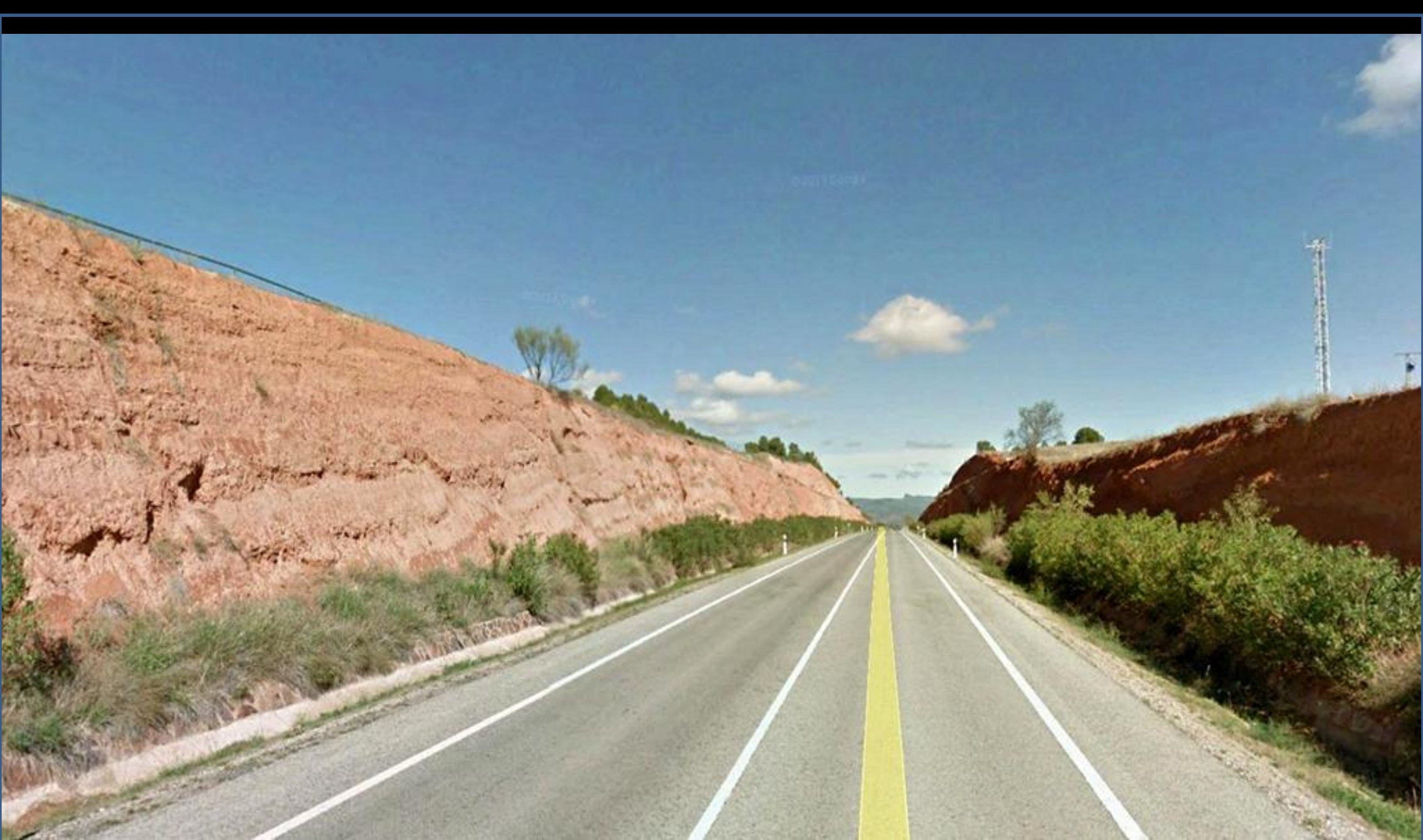
Taludes de arcillas y conglomerados, del Plioceno, Terciario. N 330, Hojas del Obispo, S de Ayora, Valencia. N Centro Hoja de Almansa.
