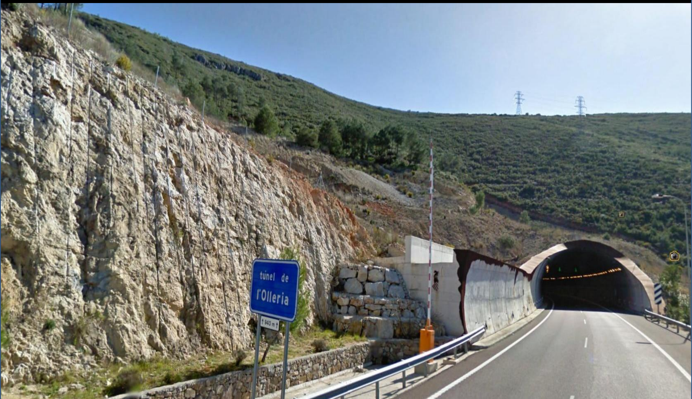
Boca N Túnel de L'Ollería. Biomicritas del Cretácico Sup. NE- Hoja- de Canals.NE- Hoja- de Canals.
