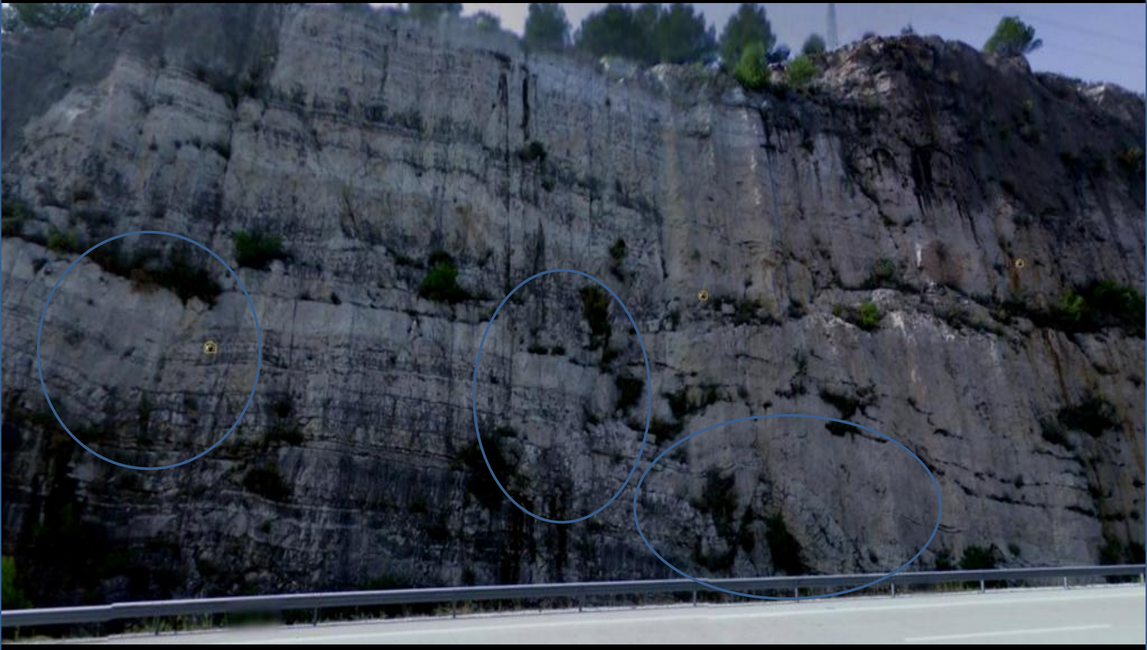
Zona fallada en las rocas carbonatadas del Cretácico Sup. Autopista del Mediterraneo. Al SW de Benirredrá. NE Hoja de Játiva.
