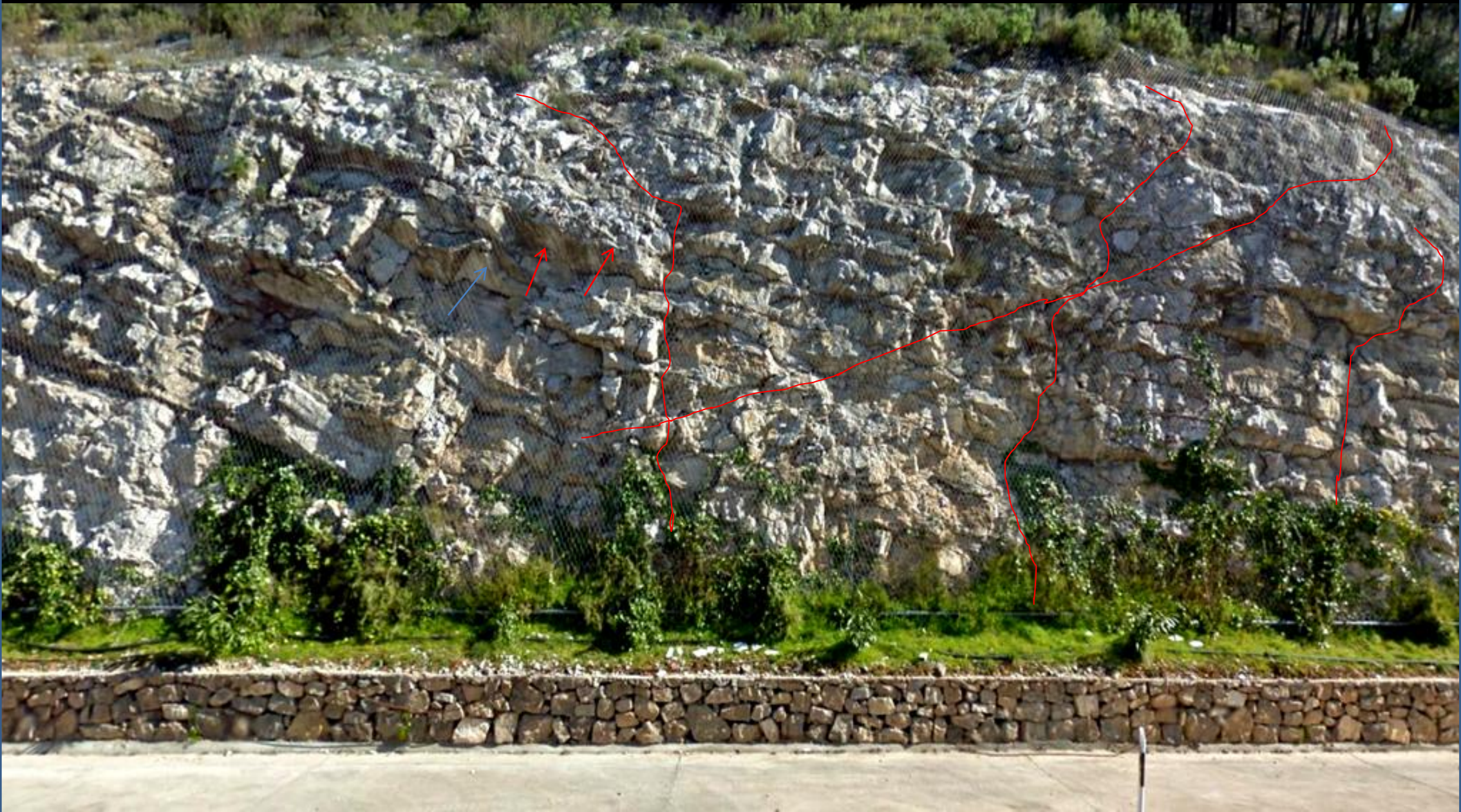
Dolomías grises del Cretácico Sup. Muy tectonizadas. Cerca de la boca N. Túnel de L'Ollería. NE- Hoja- de Canals.
