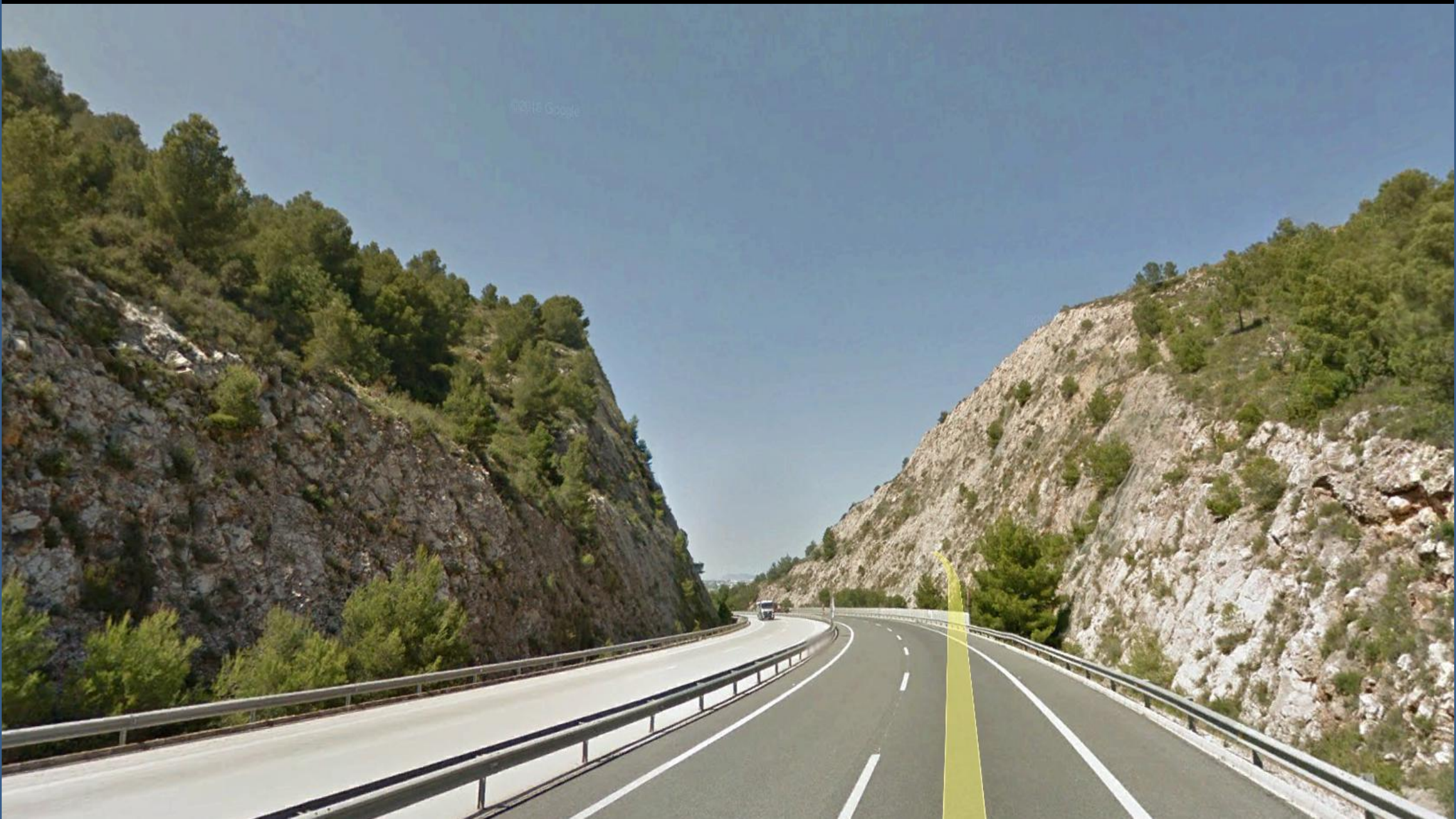
Taludes en la autopista AP7 de calizas/dolomías del Cretácico Inf. W de Oliva, Valencia. W Hoja de Gandía.
