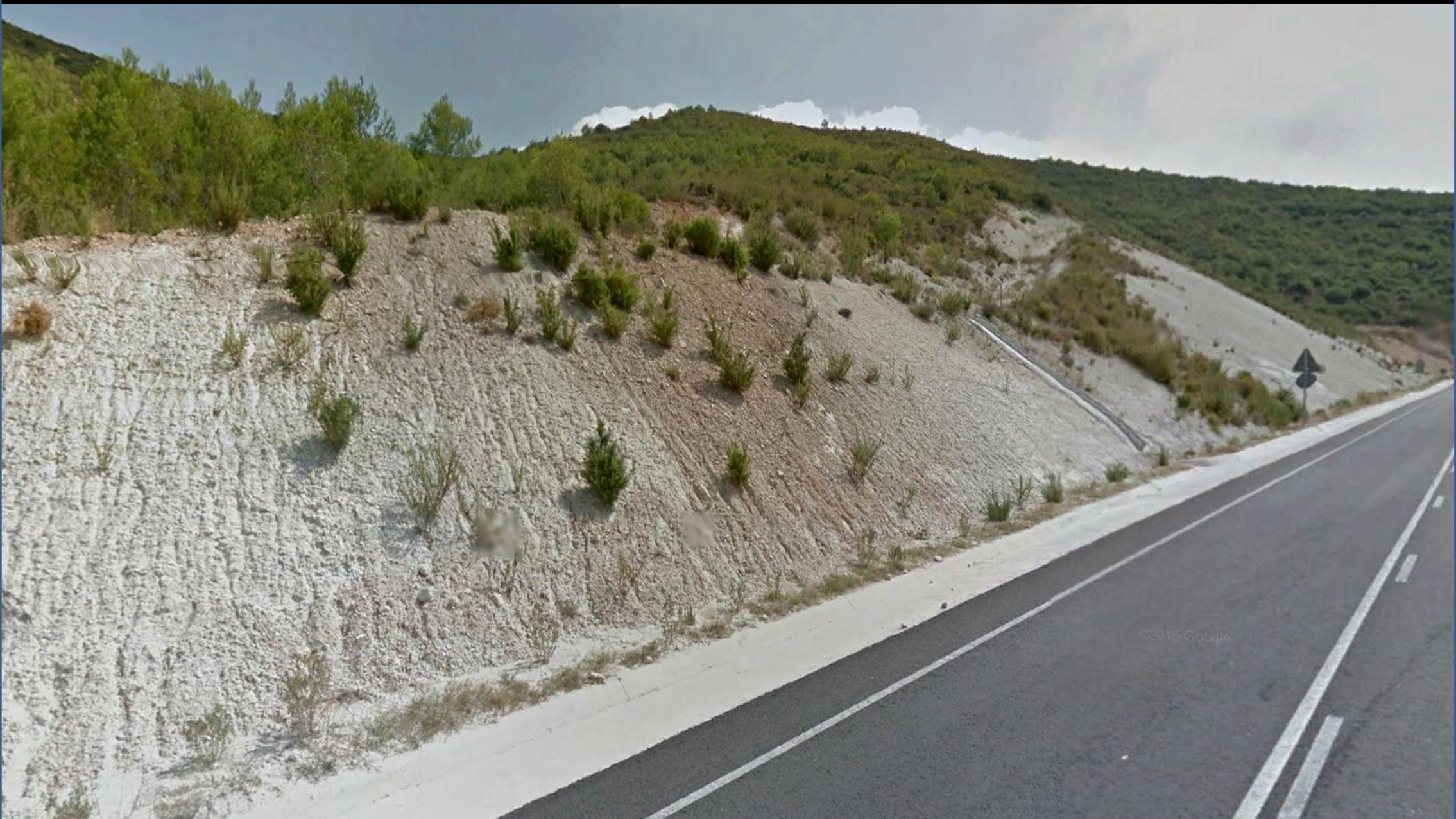
Taludes tendidos en las margas del Serravalliense, Mioceno Med. Terciario. Al W de Onteniente, Valencia. NW Hoja.
