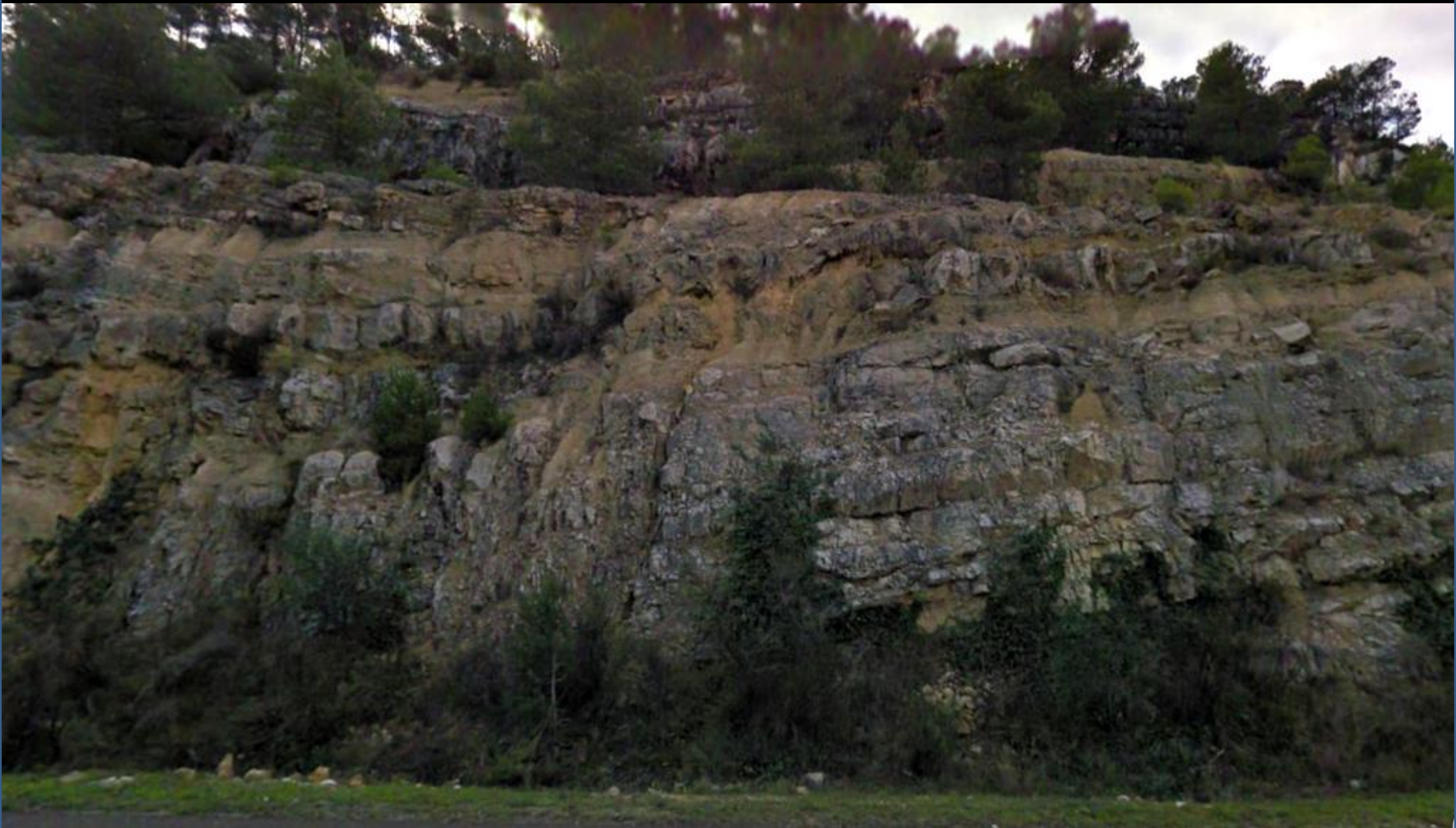
Pequeñas fallas entre las calizas y margas del Albiense. Autovía a Almansa. NW de La Font de la Figuera, Valencia. NW Hoja de Onteniente.
