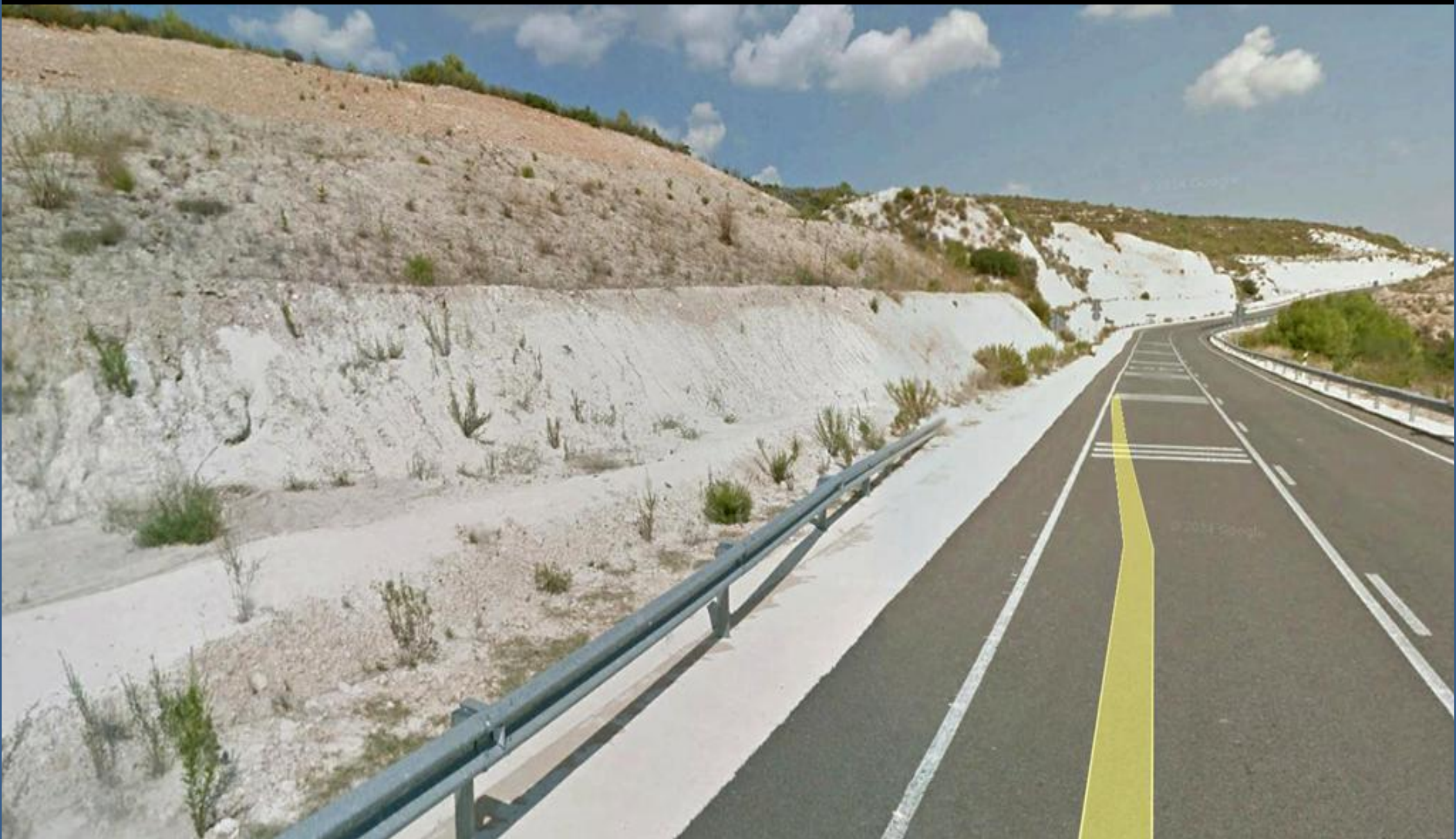
Taludes en Margas TAP del Serravallenses, Mioceno Med. Terciario. Carretera Onteniente Fontanars, Valencia. NE Hoja de O.
