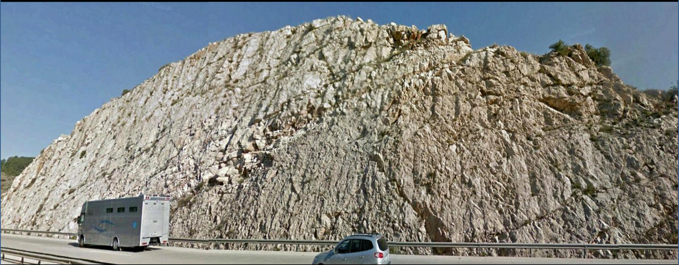
Dolomías del Kimmeridgiense, Jurásico. Fallas. Autopista del Mediterráneo. W de Oliva, Valencia. W Hoja de Gandía.
