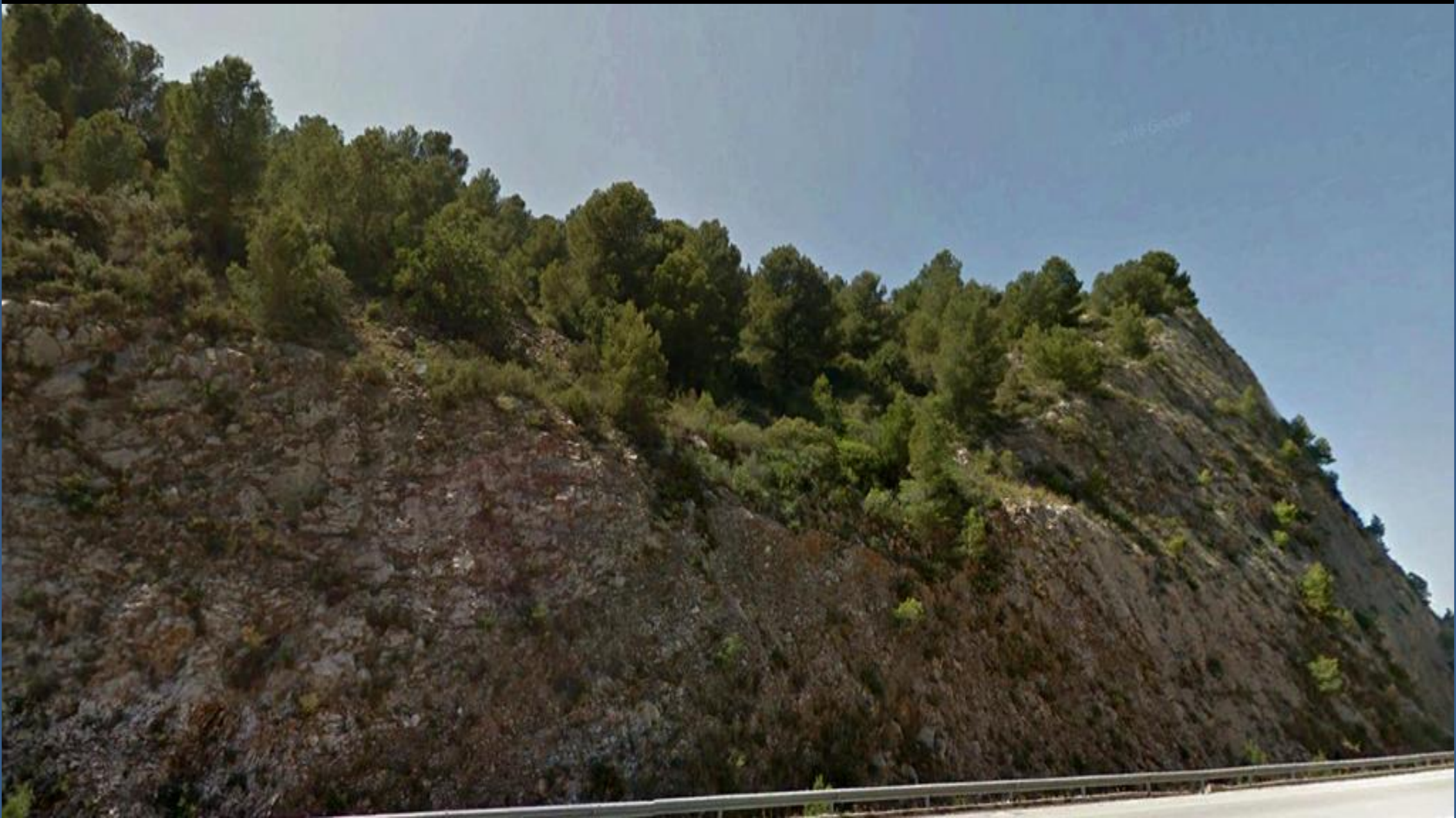
Detalle en anterior: Talud en la autopista AP7 de calizas/dolomías del Cretácico Inf. W de Oliva, Valencia. W Hoja de Gandía.
