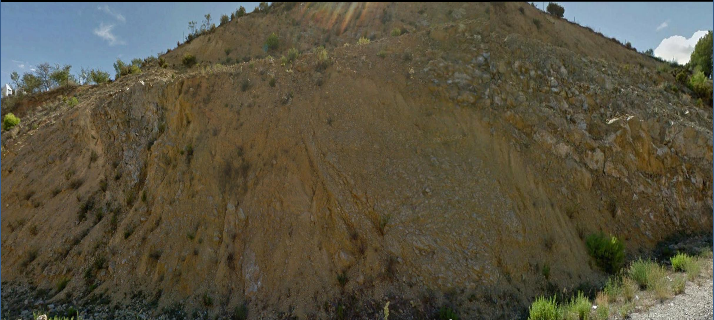
Frente a la anterior: Talud del Albiense, Cretácico Inf., tectonizado, meta-estable. N del Monte Silla, NW de Fuente La Higuera, Valencia. NE Hoja de Caudete.
