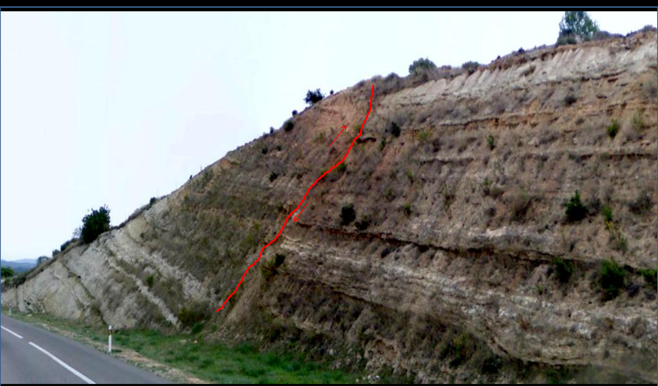
Falla – y posibles estructuras de arrastre- en las margas del Neógeno, Terciario. Autovía E. S de Chiva. Centro N Hoja de Cheste.
