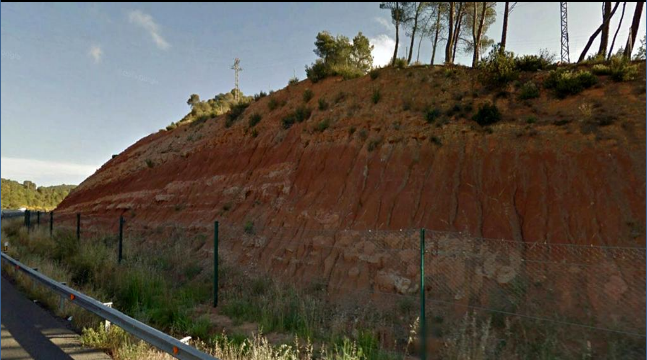
Margas arcillosas rojas, limolíticas, del Mioceno Inf. Terciario. SE de Siete Aguas, Valencia. NE Hoja de Requena.
