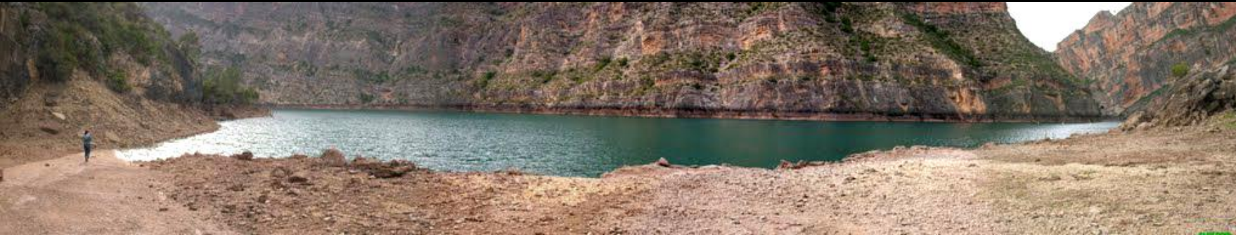
Cerrada Embalse del Naranjero. Cortes de Pallás, SW de Dos Aguas, Valencia. En Cretácicos. NE Hoja de Jalance. (por cayyete-google) Panorámica (por gasolina600-google)
