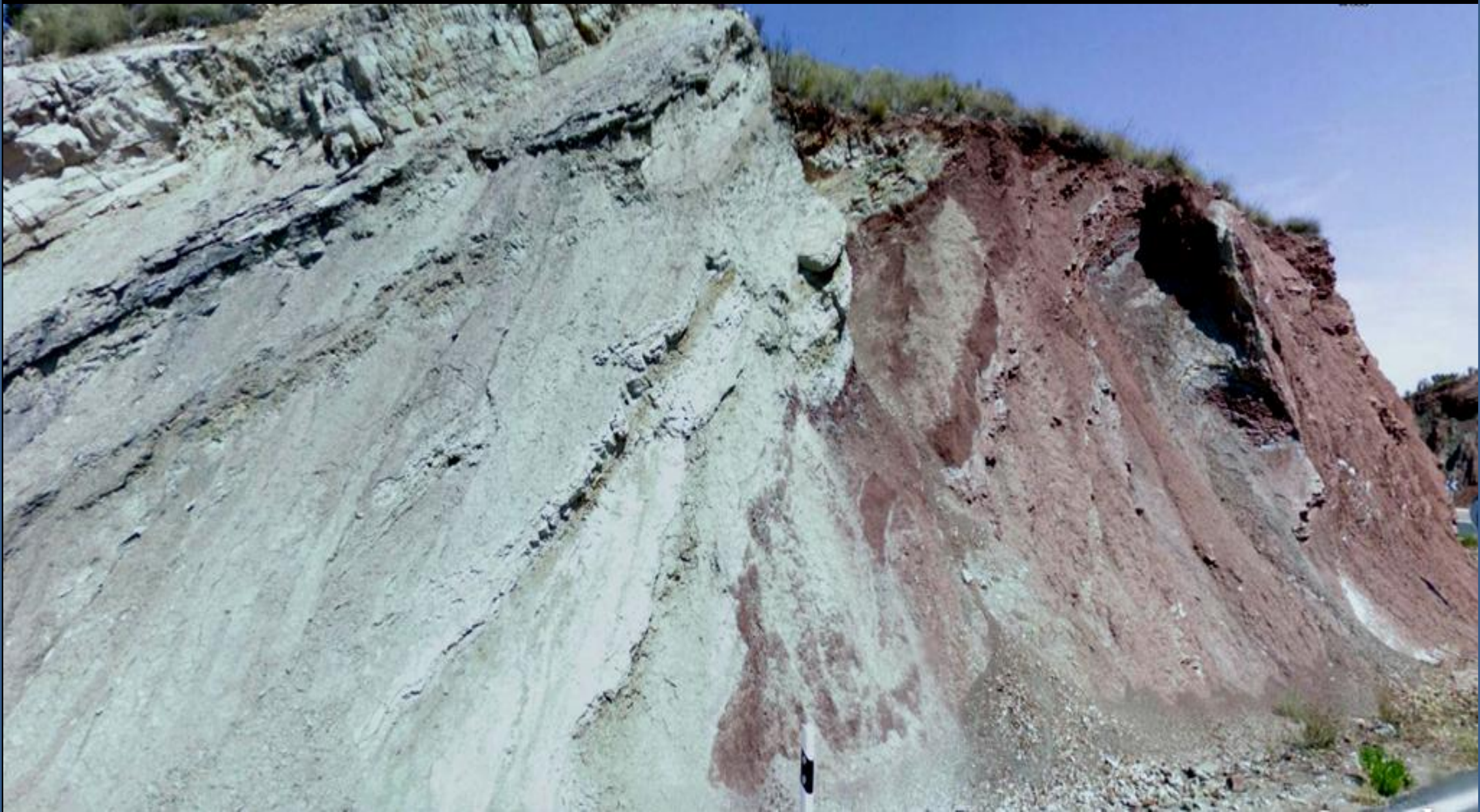
Detalle de la anterior de los taludes del Keuper. Carretera a Cofrentes, al NE del cerro de El Ahorcado. Centro W Hoja de Jalance.
