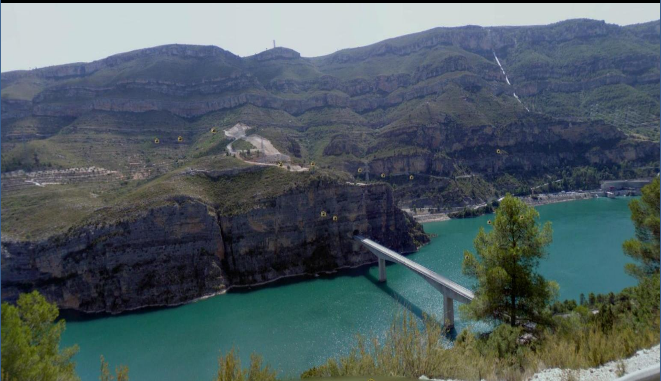
Obras hidráulicas en El Cretácico de Cortes de Pallás. E. Hoja de Jalance.
