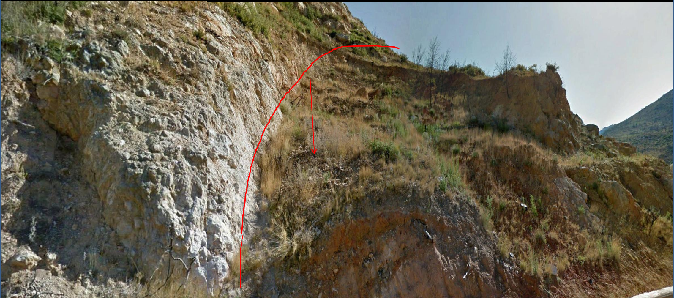
Deslizamiento-falla?. Depósitos de ladera y del Paleógeno, Terciario. Carretera, al E de Dos Aguas, Valencia. NW Hoja de Llombay.
