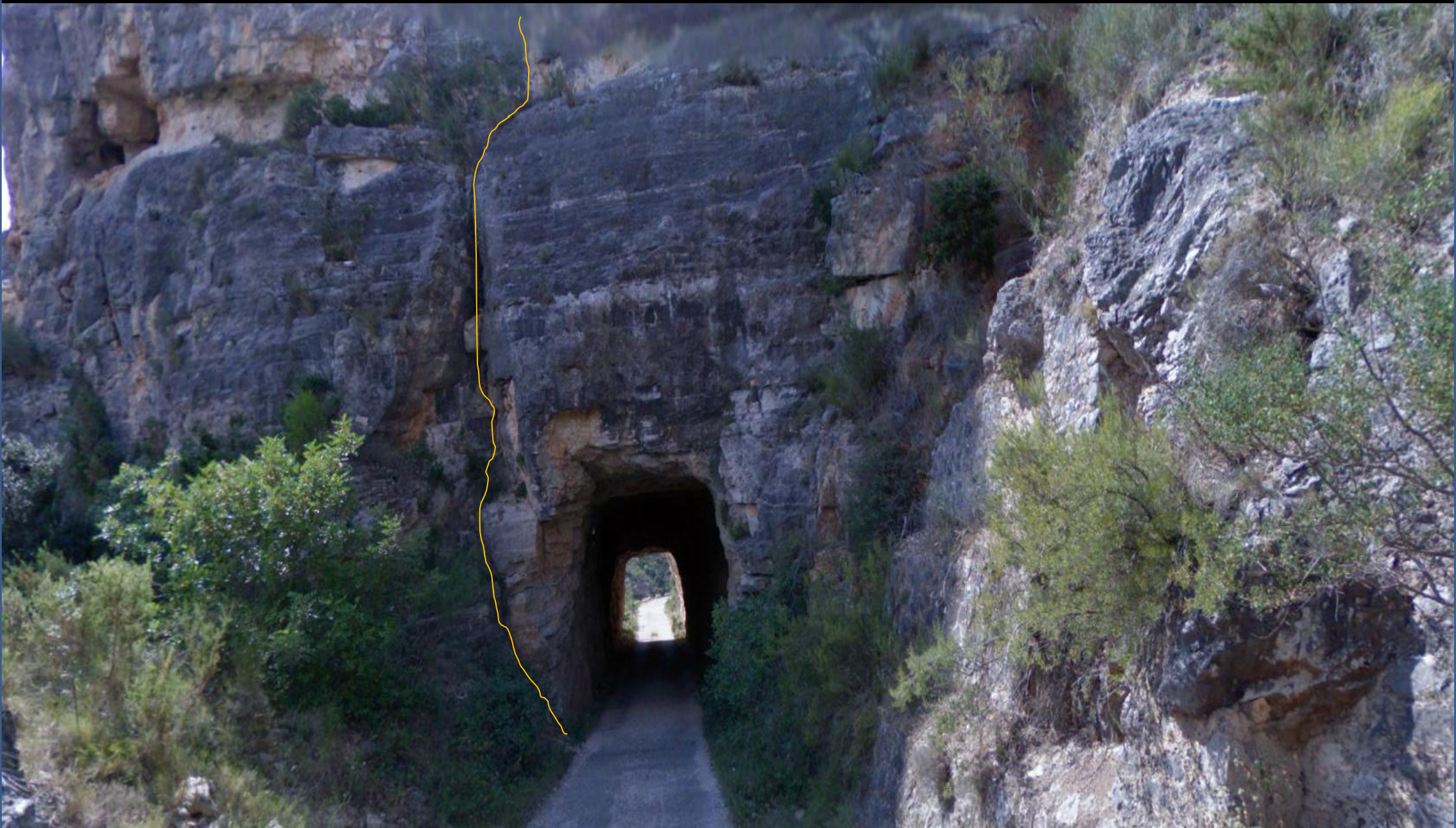
Calizas del Cretácico Sup. Túnel sin revestimiento. Solo diaclasa?. NE de Pino Carnicero. W Hoja de Llombay
