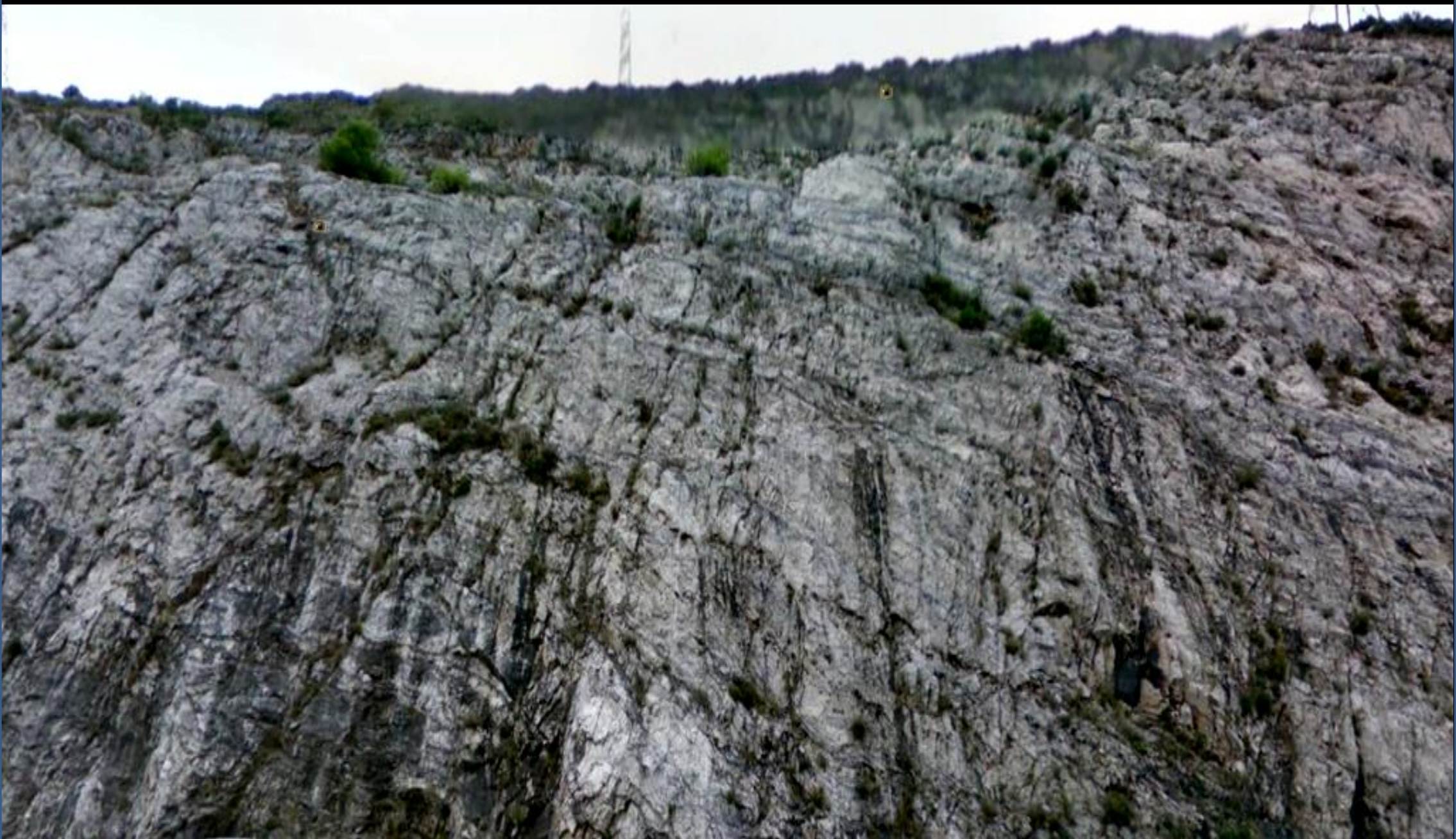
Fallas en las dolomías y calizas del Cretácico Sup.- del talúd de la Autopista del Mediterráneo.NW de Jaraco- Xeraco- . E Hoja de Alcira-Levesa
