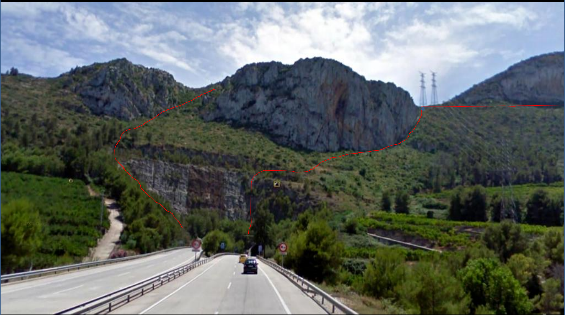
Entrada N túneles de Autopista al SW de Jersa- Xeresa- entre formaciones del Cretácico Sup., muy tectonizadas. SE Hoja de Alcira-Levesa
