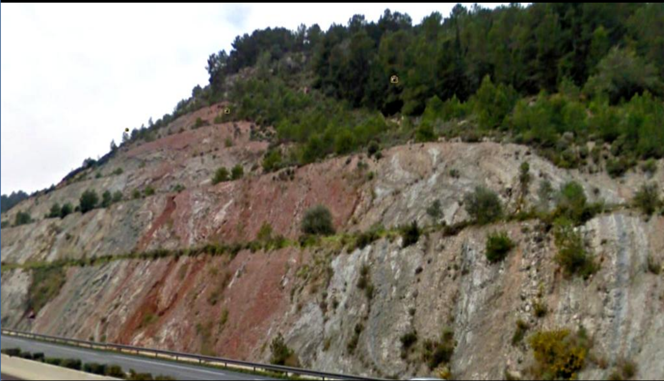
Arcillas versicolores y yesos del Keuper, Triásico. Autovía del Mediterráneo. NW de Llosa de Ranes. SE Hoja de Navarrés.
