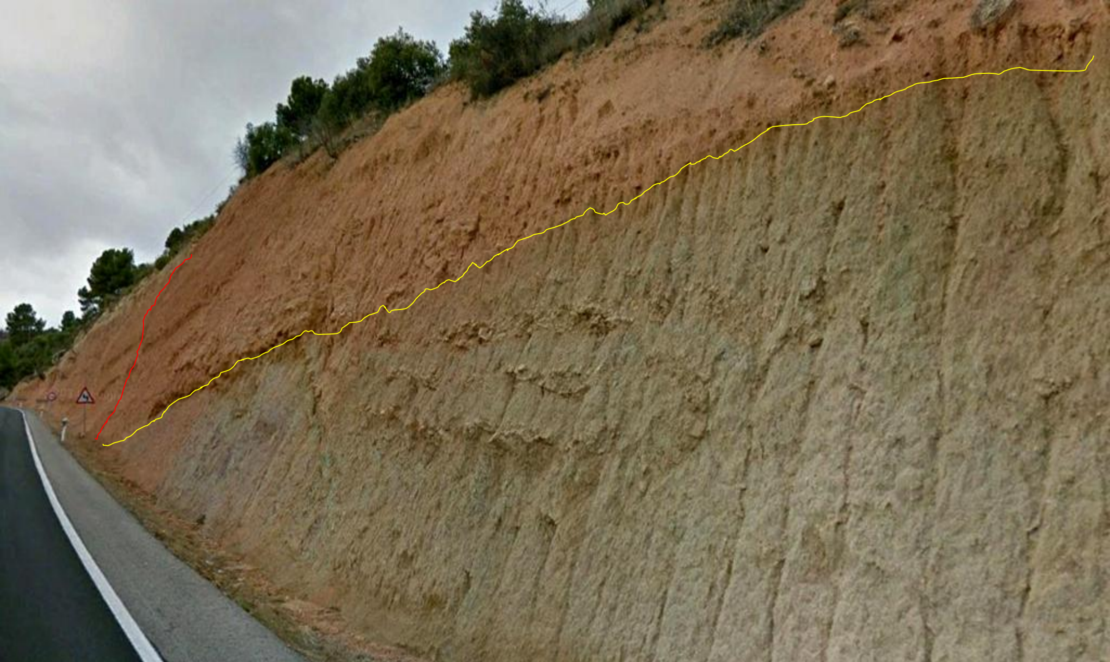
Discordancia entre depósitos arcillosos rojos del Terciario, y arcillas del Keuper, Sup. Y pequeña falla. N de Jarafuel, Valencia. NW Hoja de Ayora.
