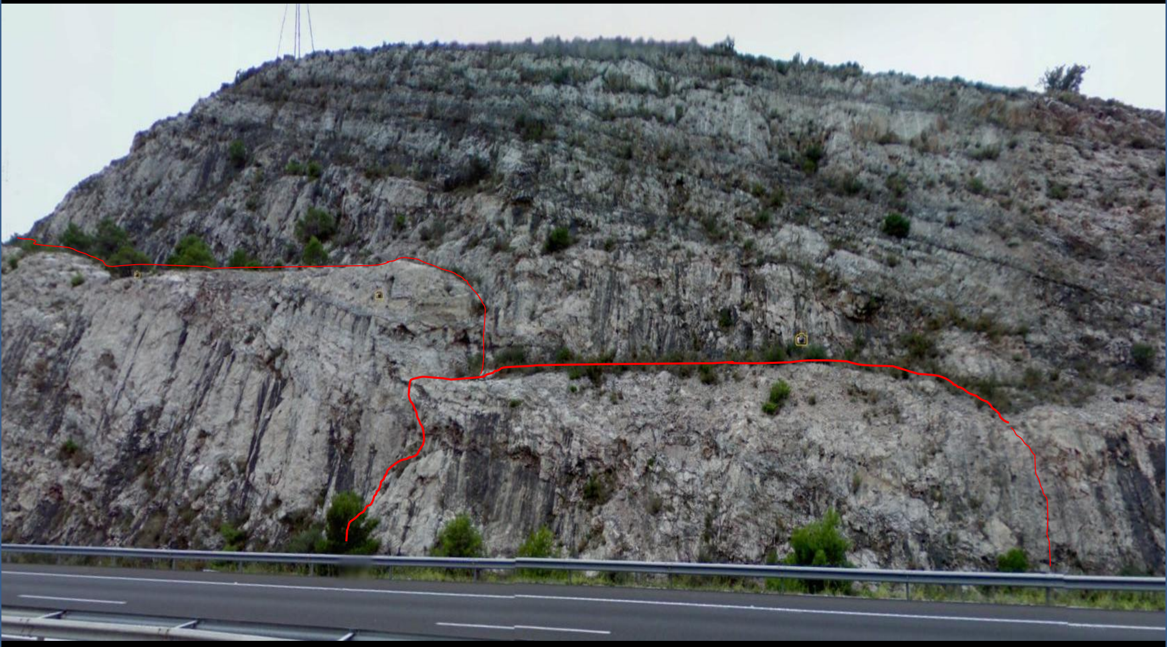
Fallas en las dolomías y calizas del Cretácico Sup.- del talúd de la Autopista del Mediterráneo.NW de Jaraco- Xeraco- . E Hoja de Alcira-Levesa
