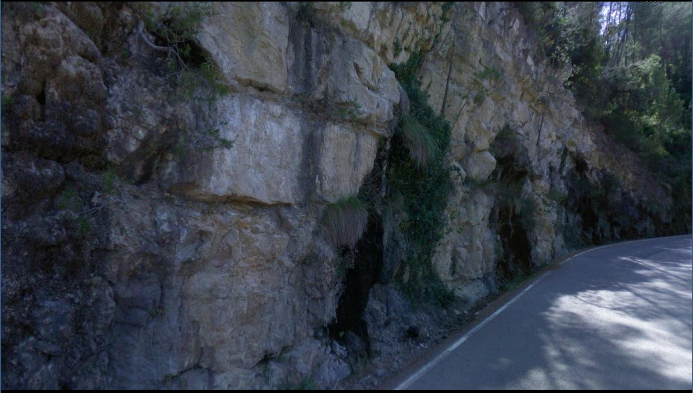
Detalle ampliado de imagen anterior: Calizas arcillosas del Dogger, Jurásico Med. y surgencias de agua en el talud. Zona W Embalse de Benageber, Valencia. SW Hoja de Chelva
