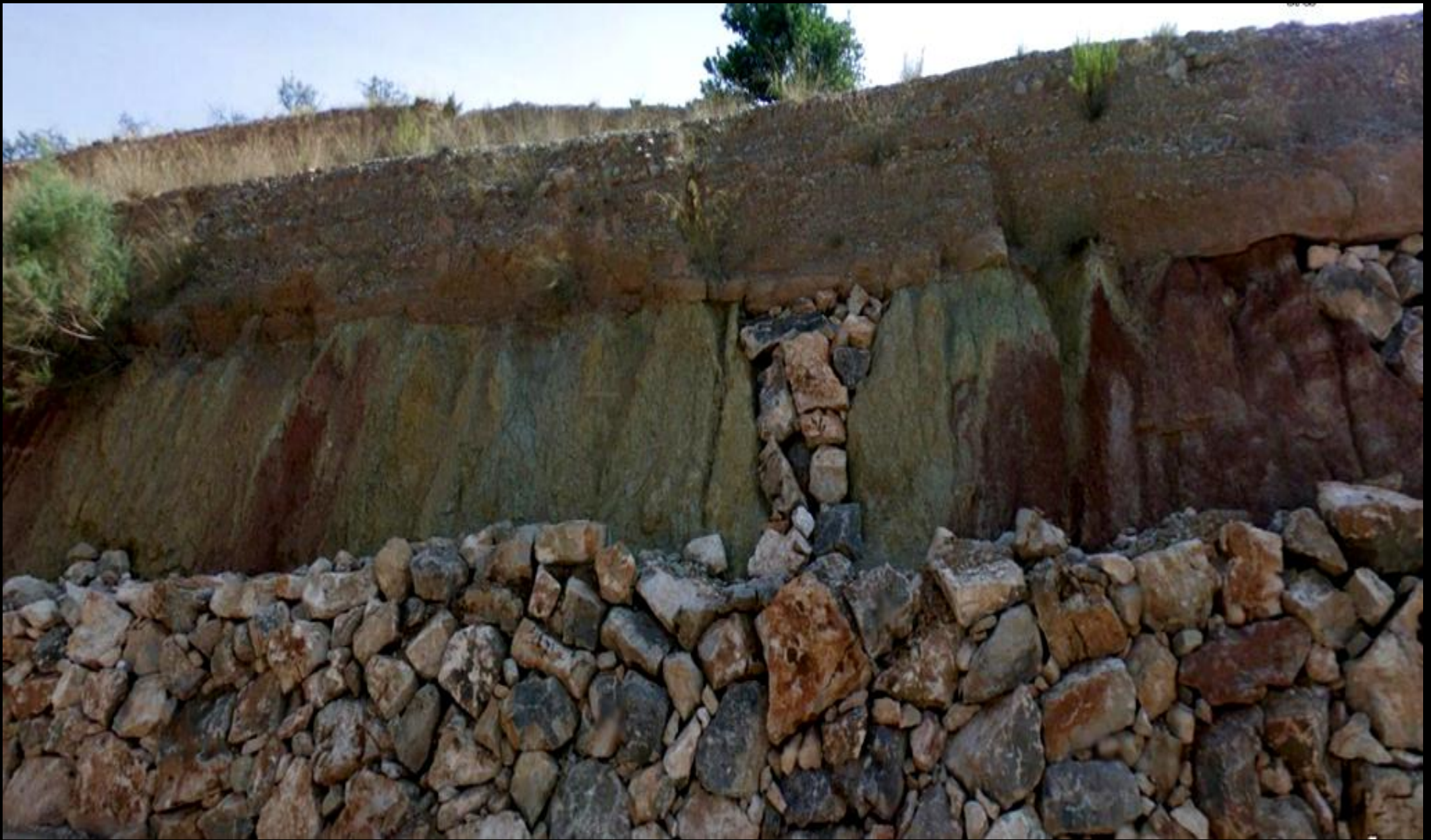
Actuaciones en talud de sedimentos fluviales Cuaternarios sobre arcillas versicolores del Keuper Triásico. Al NW de Calles. Centro Hoja de Chelva.
