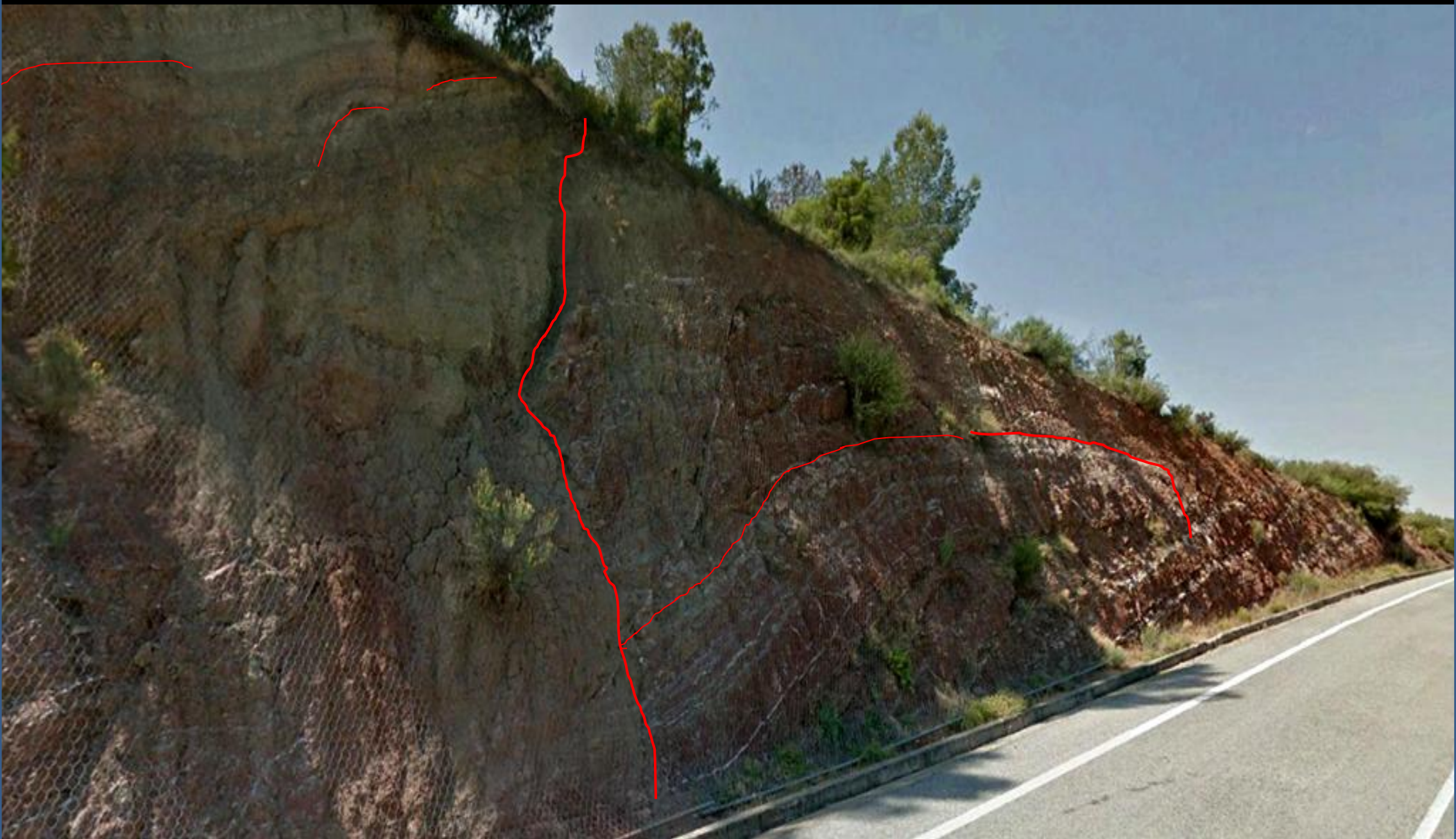
Detalle de anterior: Mallazo sobre margas y arcillas versicolores del Keuper, Triásico Sup. Falla por halocinesis de los yesos. NW de Tuéjar, Valencia. NW Hoja de Cherlva.
