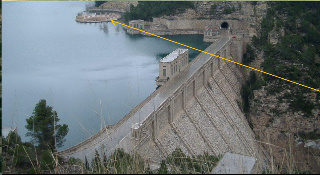
Embalse de Benageber, Valencia. En Mesozoicos. W Hoja de Chelva. Cerrada y Morning glory (por abarrajón/Francisco Vilanova-google)
