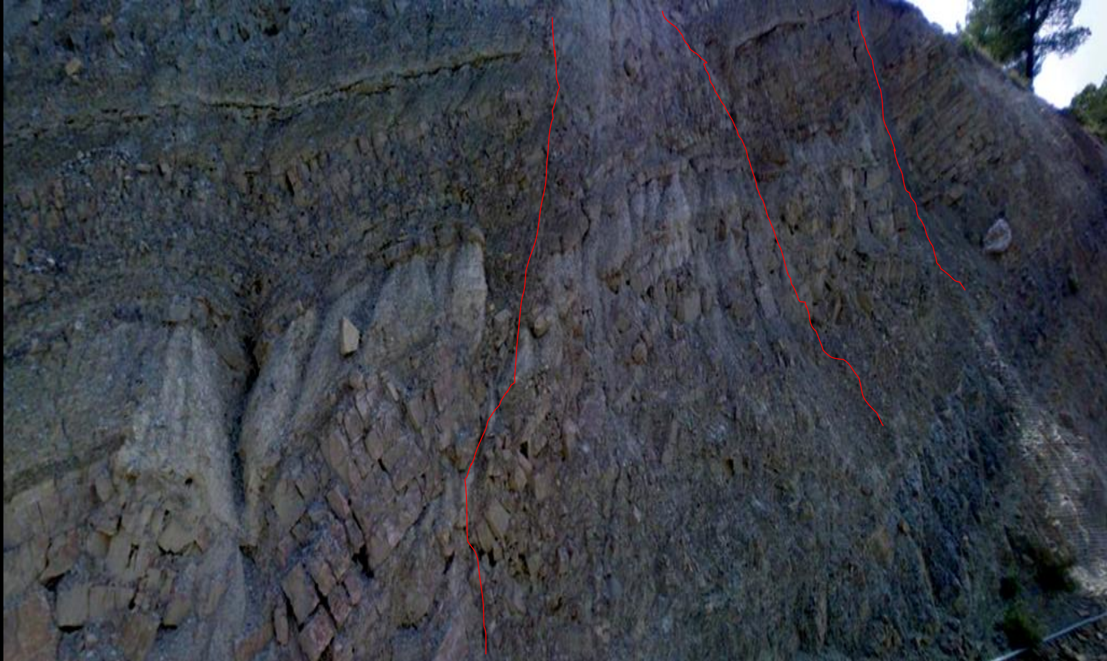
Pequeñas fallas en las arcillas y margas, Keuper, Triásico. Junto Rambla de las Roturas. NW de Tuéjar, Valencia. NW Hoja de Chelva
