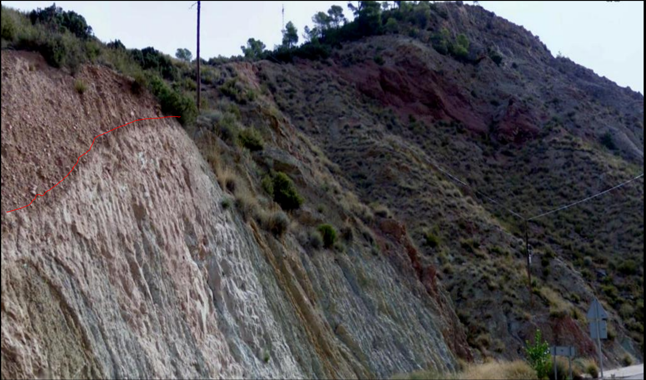
A izquierda Cuaternario fluvial; en medio, arcillas versicolores Keuper; en cima, dolomías del Muschelkalk. Al SE de Calles. Centro Hoja de Chelva.
