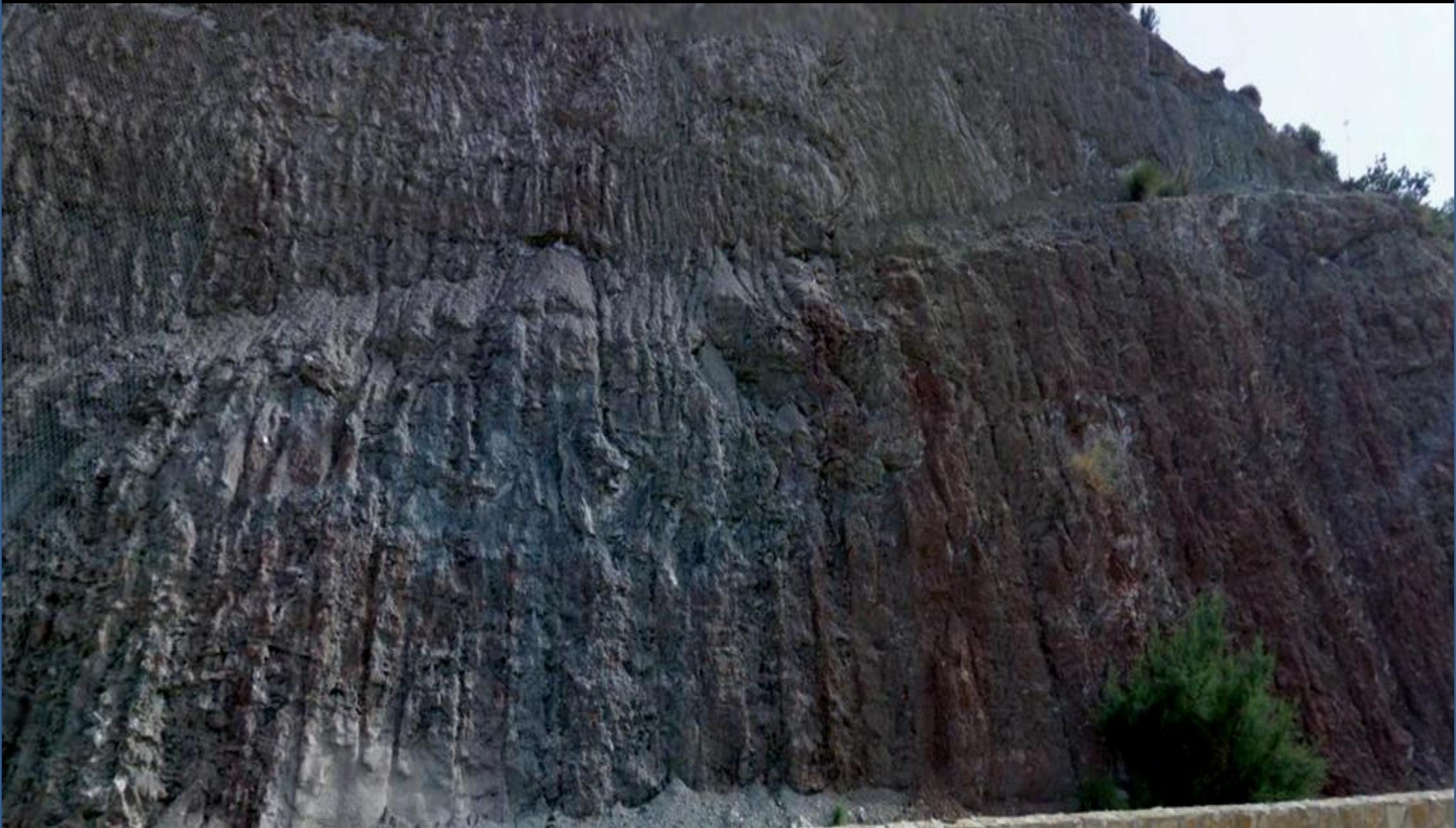
Detalle de imagen anterior, obsérvese el mallazo de protección. Talud de material arcilloso con yesos Keuper. Al SE de Calles. Centro Hoja de Chelva.
