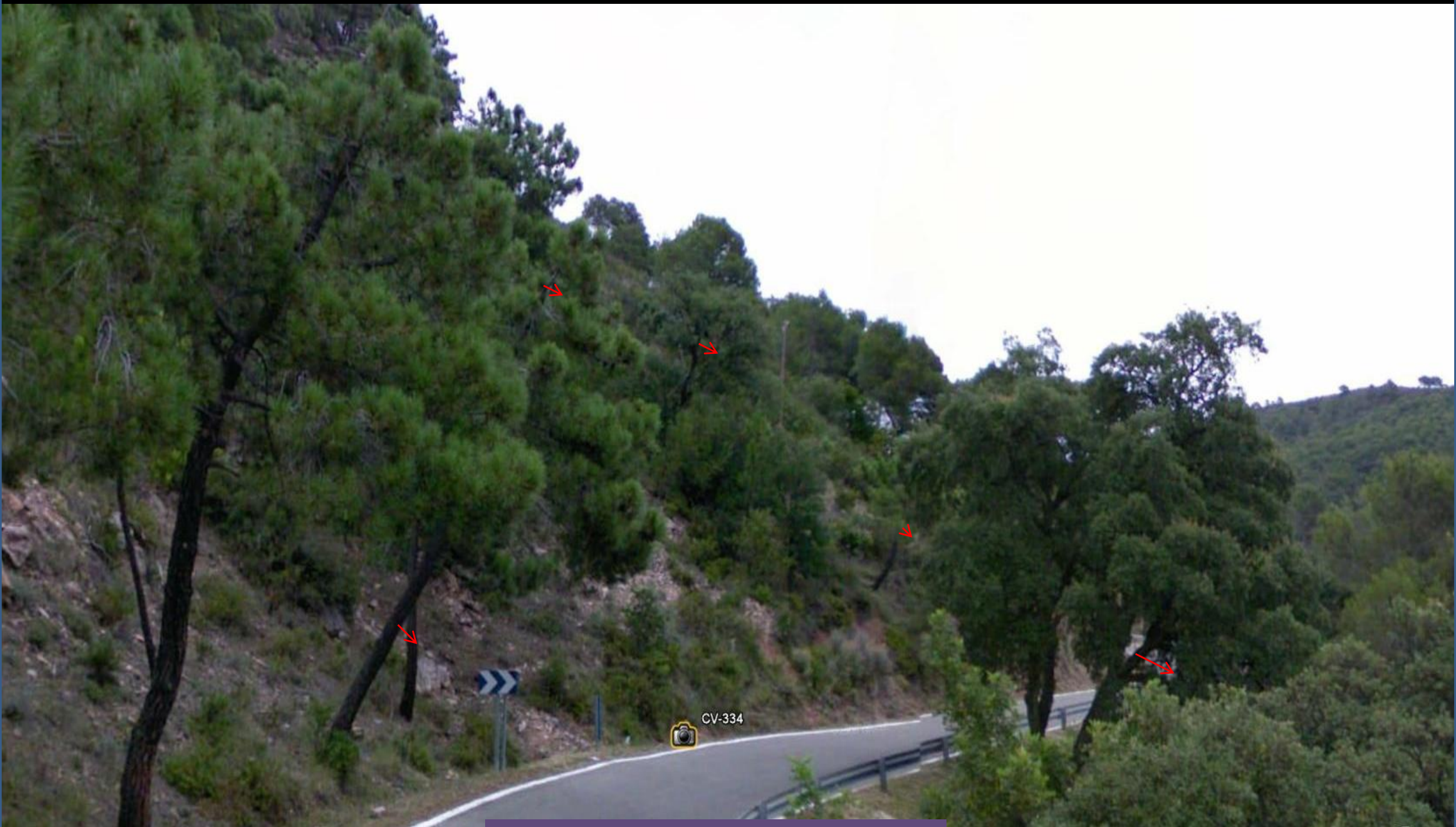
Ladera que desliza?. en las areniscas del Buntsandstein, Triásico. NW de Barraix. S Hoja de Sagunto.
