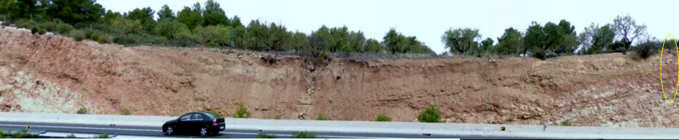
Talud de autopista con pliegues abiertos y fallas en dolomías y calizas del Liásico, Jurásico Inf. W de Villagordo del Cabriel. SW Hoja de Utiel. (imagen seccionada)
