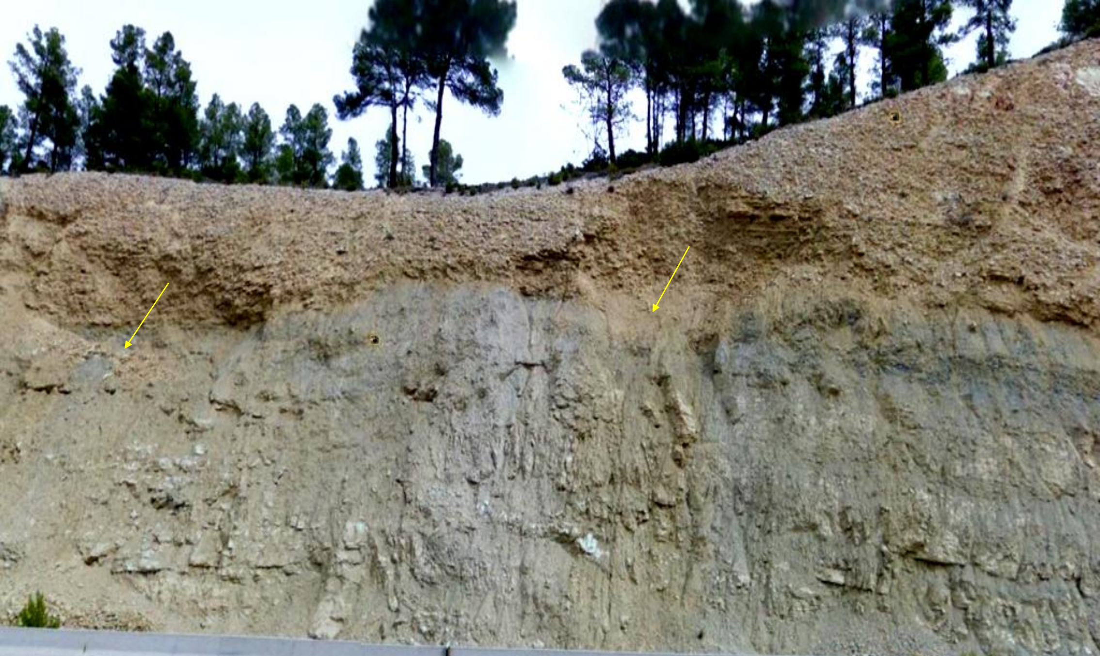
Inestabilidad en talud en dolomías y calizas microcristalinas del Liásico, Jurásico Inf., y en zona de cabalgamiento. Autopista. W de Villagordo del Cabriel. SW Hoja de Utiel
