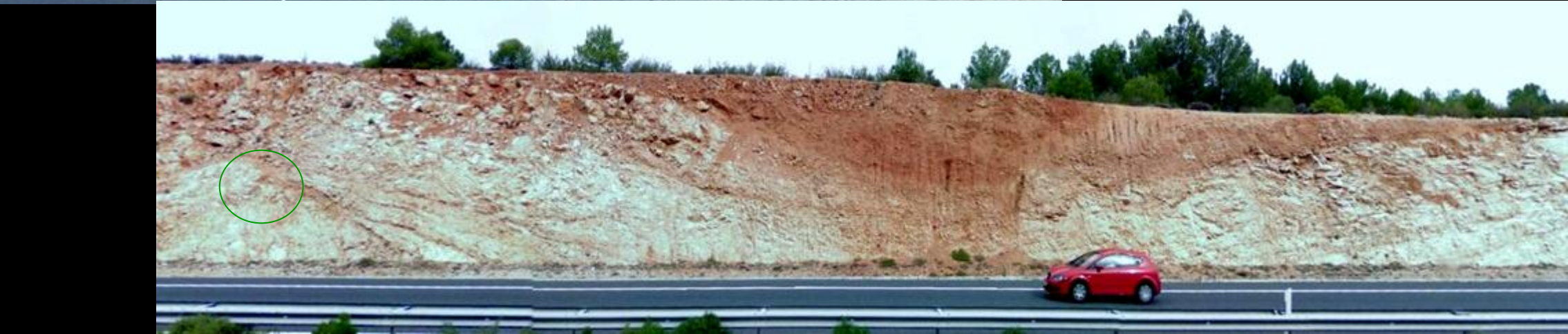
Talud de autopista con pliegues abiertos y fallas en dolomías y calizas del Liásico, Jurásico Inf. W de Villagordo del Cabriel. SW Hoja de Utiel. (imagen seccionada)
