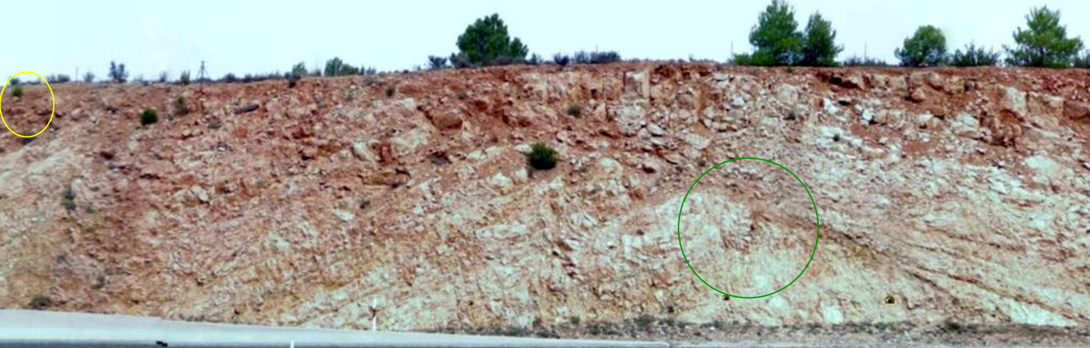
Talud de autopista con pliegues abiertos y fallas en dolomías y calizas del Liásico, Jurásico Inf. W de Villagordo del Cabriel. SW Hoja de Utiel. (imagen seccionada)
