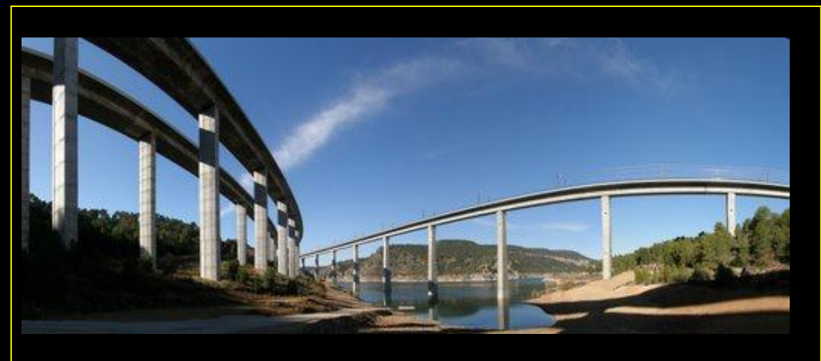
Embalse de Contreras. (foto de El Castor-Google) / desde el Viaducto del Istmo A-3 (El Castor)/ Viaductos AVE y Autovía Madrid- Valencia (SDMV)
