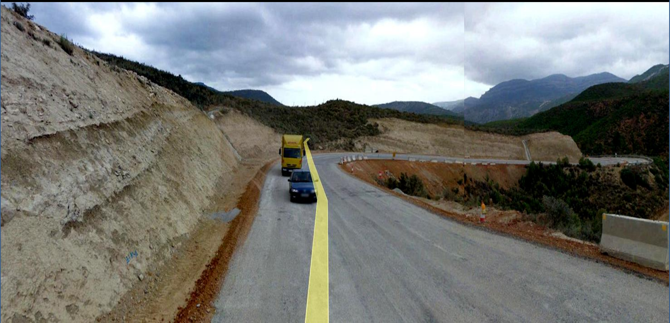
Obras de adecuación del talud de margas arcillosas Vindoboniense, Mioceno, Terciario. SW de Chera, N de El Rebollar, Valencia. Centro S Hoja de Chulilla.
