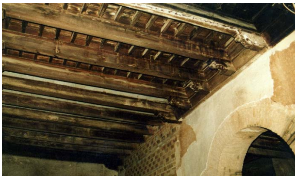
Figura 3: La Nave Norte antes de 1989. Fotos: Iván Jimenez.
