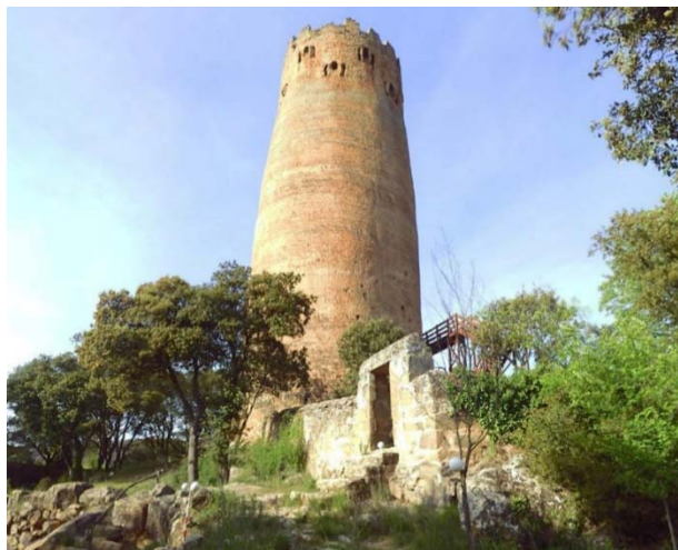
Figura 1: Vista de la Torre Vallferosa. GLOBAL GEOMÁTICA
