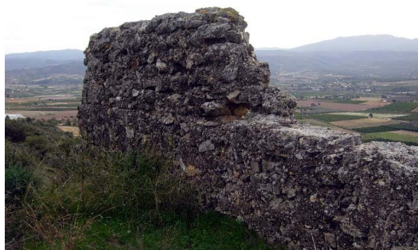
Figura 9: Parapeto aspillerado del siglo XV conservado en su totalidad hasta su acabado en albarda. Forma parte del lado oeste de la muralla.
