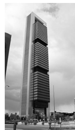
FIG_31. Torre Cepsa, Madrid. Rascacielos puente.
