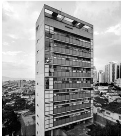
FIG_60. Edificio Jaraguá.
