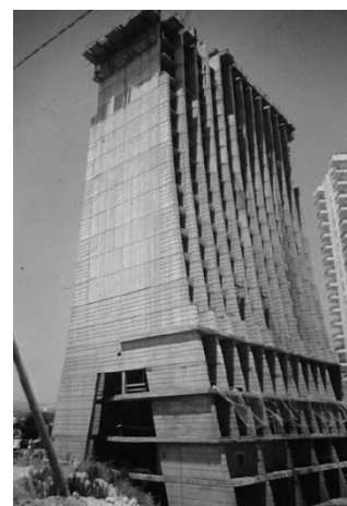
FIG_30. Construcción hotel Bali, Benidorm. Estructura de pantallas.
