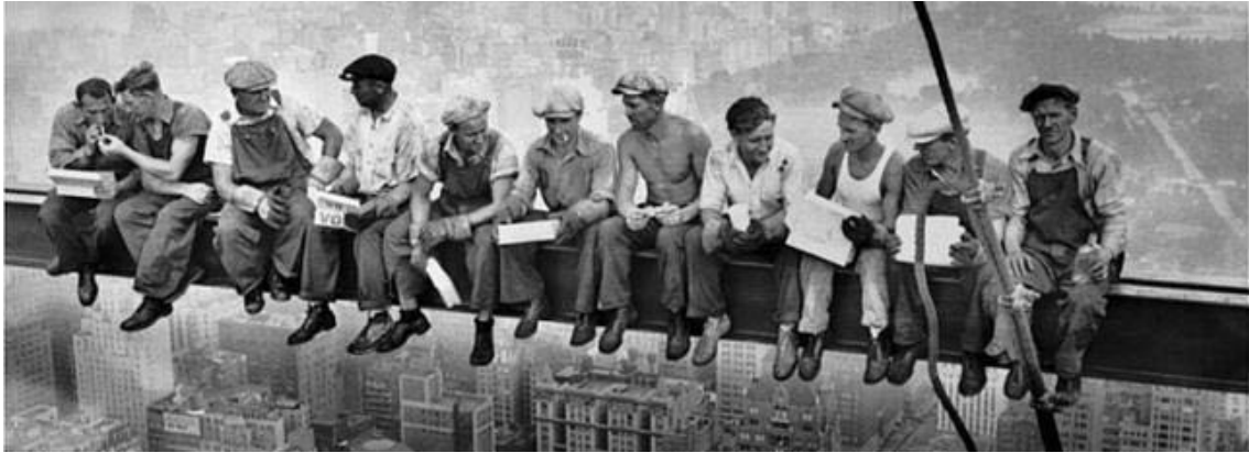
FIG_36. Obreros en un descanso de la construcción de un rascacielos.
