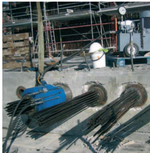
Imagen 4.16 Gato hidráulico para pretensado
