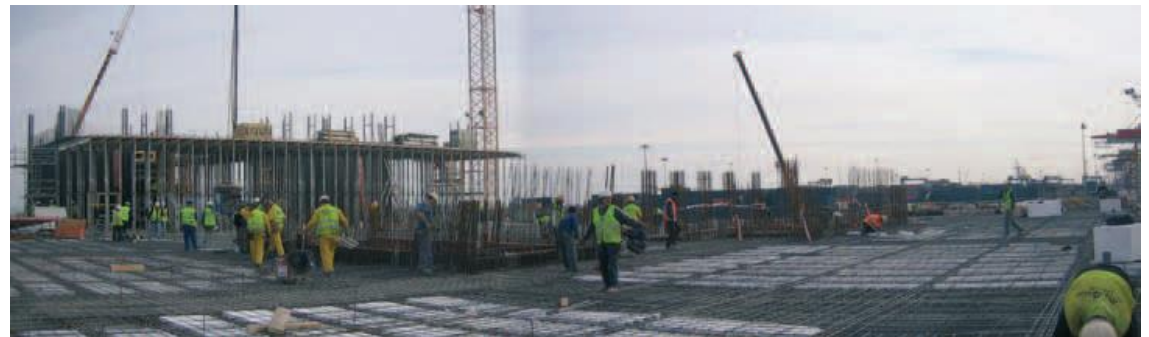
Imagen 2.14 Construcción de un forjado del Veles e Vents
