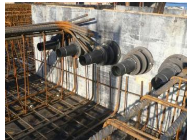
Imagen 4.17 Batería de trompetas de postesado
