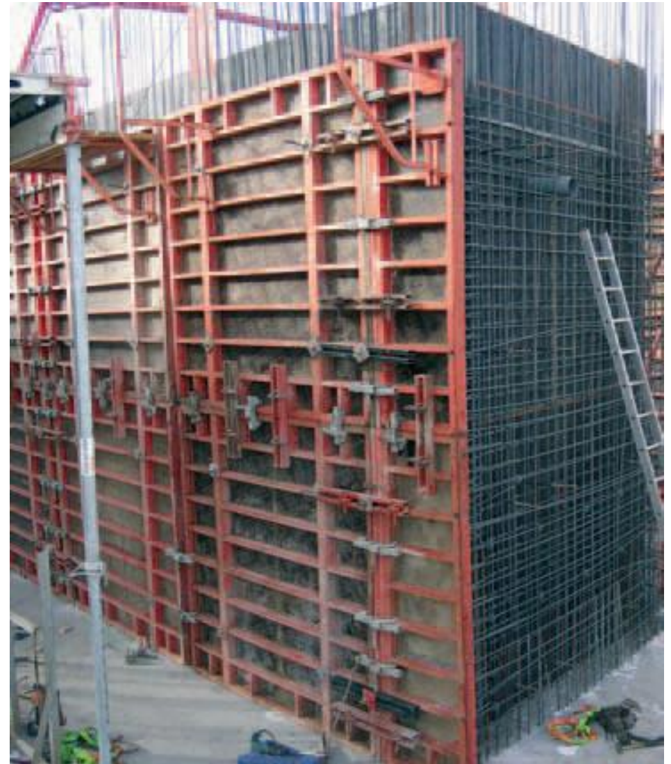
Imagen 3.3 Encofrado de los soportes del Veles e Vents
