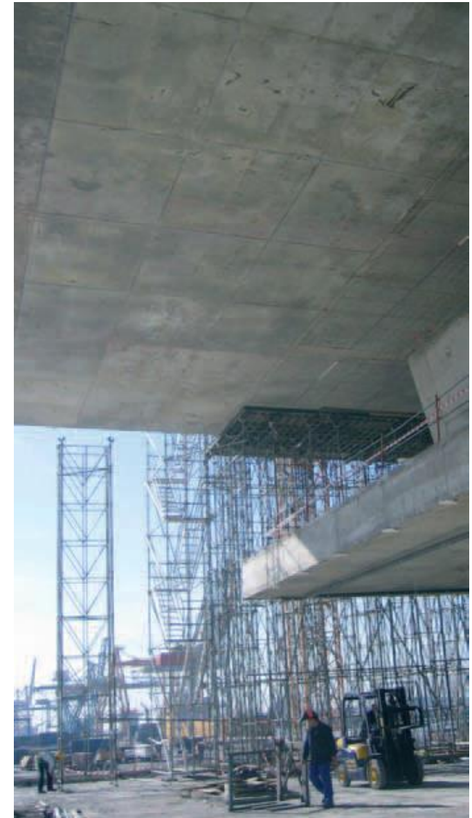
Imagen 2.15 Cimbrado del forjado de tercera planta
