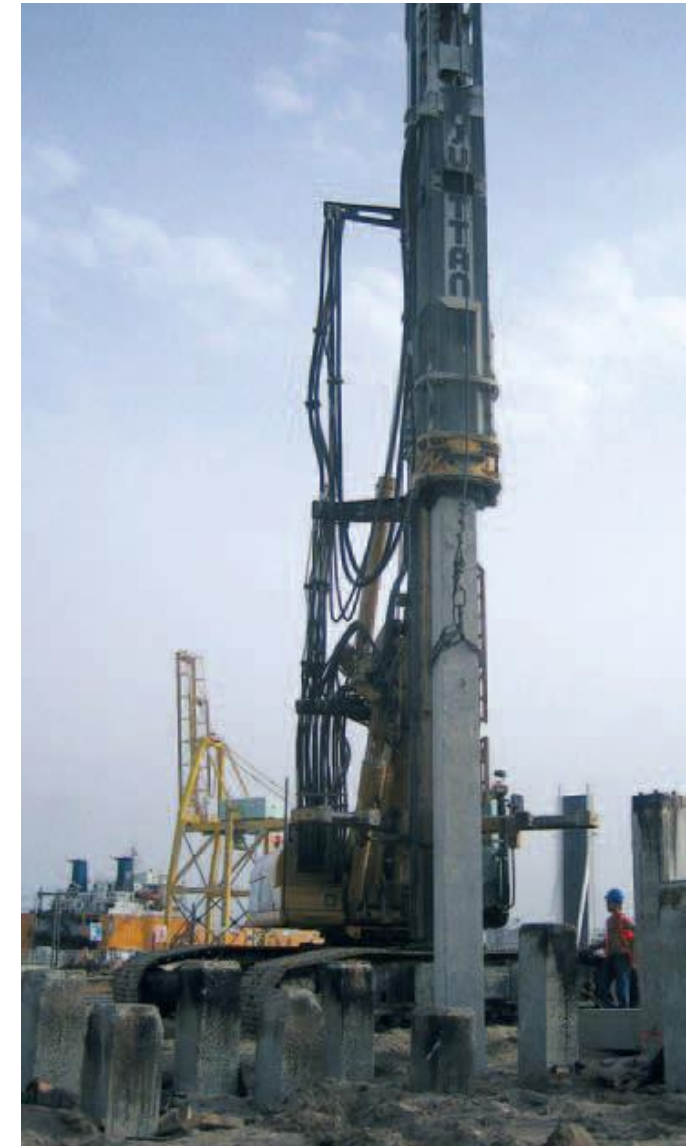
Imagen 3.4 Hincado de los pilotes en el Veles e Vents
