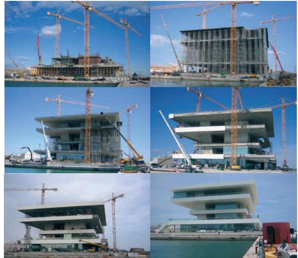
Imagen 2.13 Evolución de la construcción del veles e Vents de Enero a Mayo del 2006
