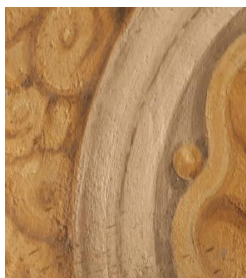
Figura 35. Superficie arriccio .
