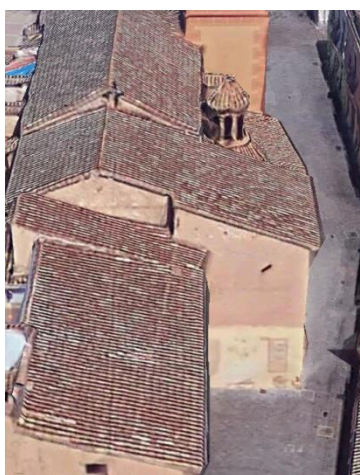
Figura 56. Vista aérea cubiertas vivienda Barón de Barxeta y trasagrario.
