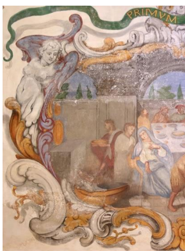
Figura 53. Escena 4, humedad por filtración.
