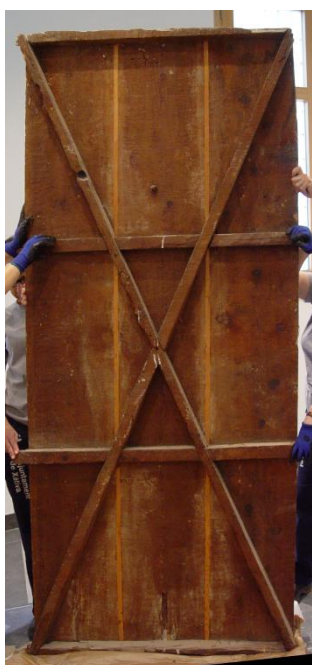
Fig. 25. Reverso del panel que contiene las escenas de El calvario y San Agustín.
