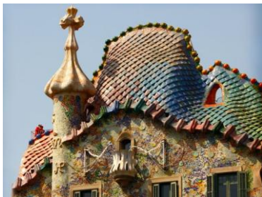
Fig.12. "Casa Batlló" (1904-1906) Barcelona.
