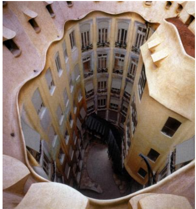
Fig.14. Patio interior de “La Pedrera” Barcelona.
