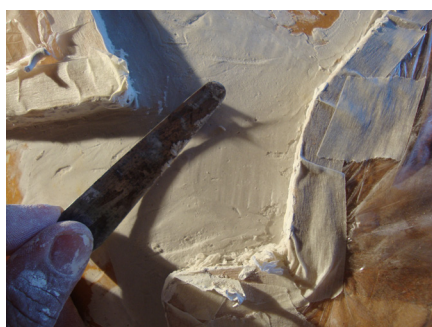
Fig. 28, 29 y 30, proceso de la aplicación del estuco.
