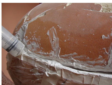
Fig. 25 y 26, humectación e inyección del estuco en las grietas.
