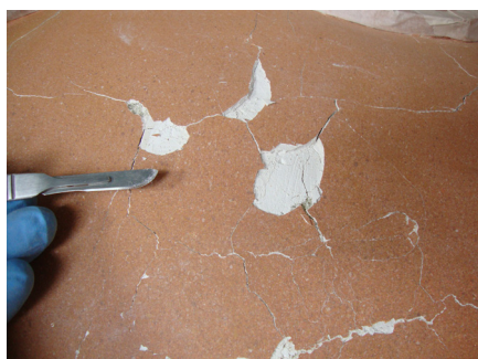
Fig. 20, proceso de la eliminación de estuco débil y saneamiento de las grietas.
