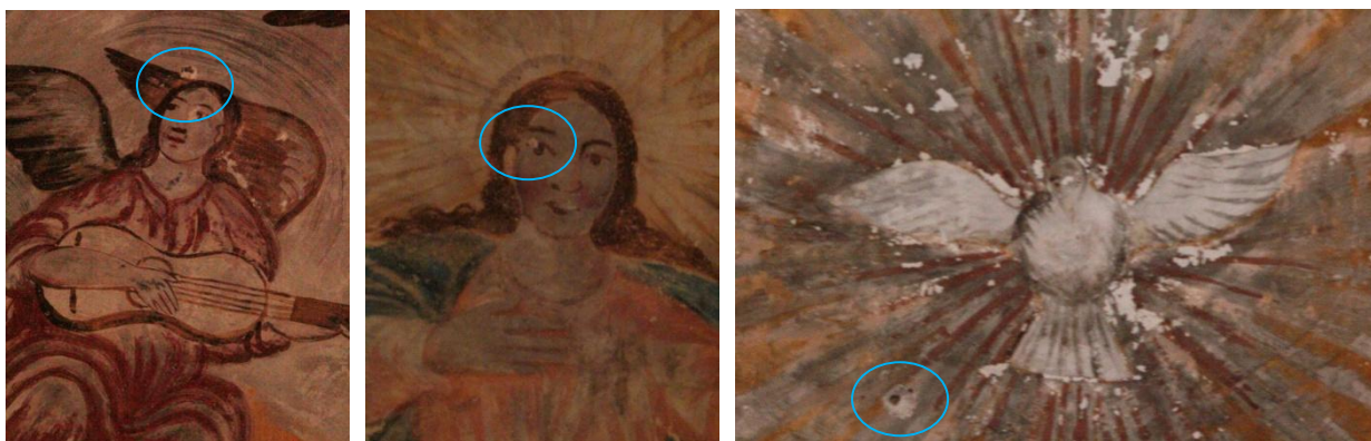
Figuras 48,49 y 50. Dos posibilidades: Impactos de perdigones o caliches por la utilización de una cal mal apagada
