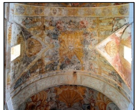
Figura 78. Vista segundo tramo
