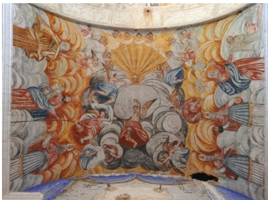
Figura 20. Vista general del ábside
