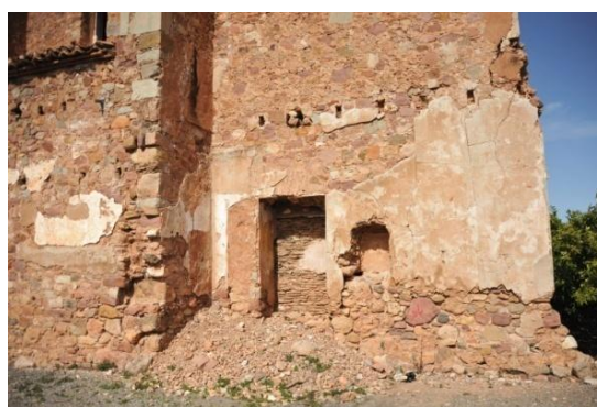
Figura 31. Puerta que comunicaba ábside y casa abadía
