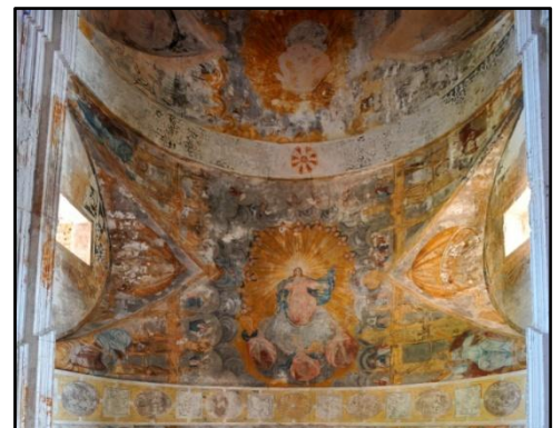
Figura 81. Vista tercer tramo
