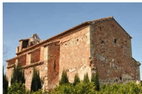
Figura 10. Fachadas sur y este
