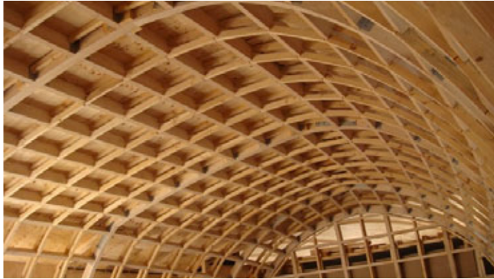
Imagen 4. Techo fabricado con madera laminada
