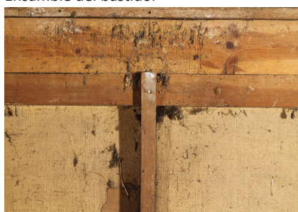
Figura 23. Unión del travesaño al bastidor
