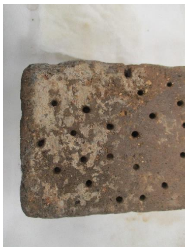
Fig.31 - Pieza humectada por antes de la aplicación del complejante.
