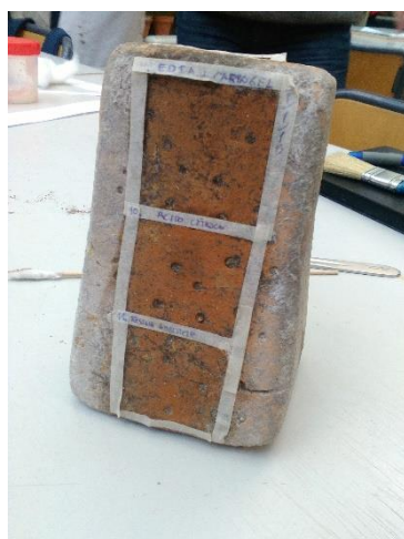
Fig.27 - Catas de limpieza físico-mecánica.
