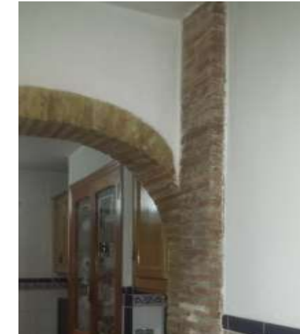
Arcos interiores ladrillo
