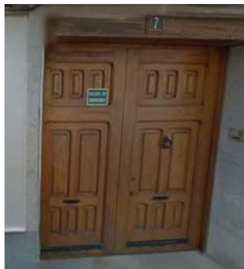
Figura 59: imagen de la puerta principal de la vivienda.
