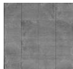
Figura 92: pavimento patio vivienda.
