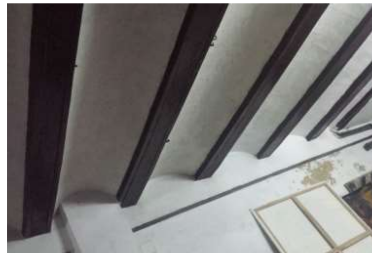
Forjado revoltón, cara inferior
