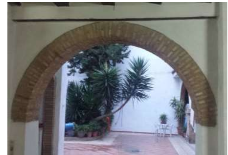
Arco rebajado muros
