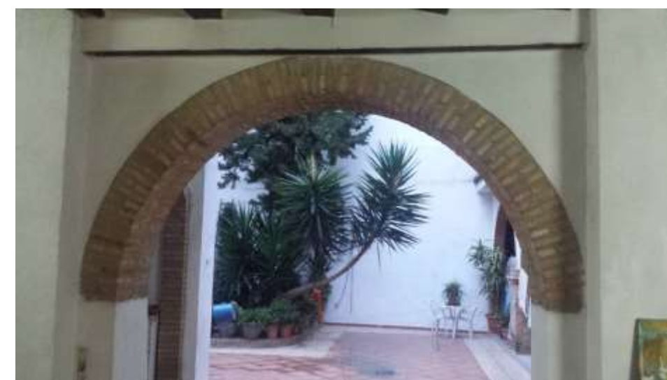
Figura 44. Fotografía del arco rebajado de ladrillo. Elaboración propia.
