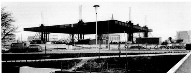
3.28 Elevación de la cubierta
