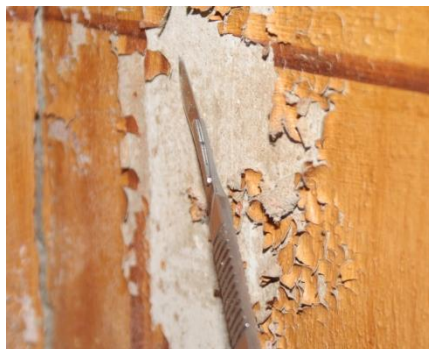
Fotografía 25. Extracción de las muestras de la pared norte.
