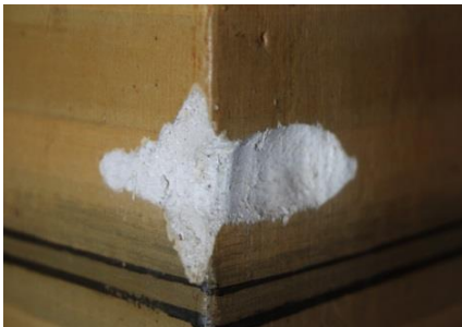
Fotografía 34. Laguna creada por los herrajes de la ventana.
