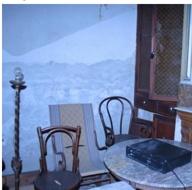
Fotografía 2. Acumulación de muebles en el habitáculo.
