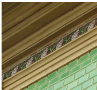
Fotografía 9. Detalle de las decoraciones con motivos florales y del ladrillo caravista color verde de la fachada de la casa señorial.
