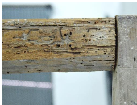
Figura 25: Ataque biológico en bastidor.
