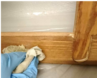
Figura 45: Proceso de encerado con muñequilla del bastidor nuevo.
