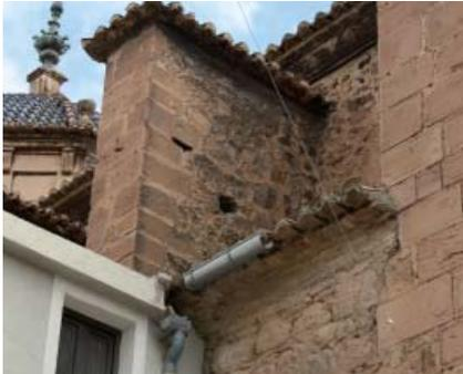
Fig 3.10: Contrafuertes.
