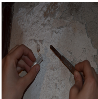
Figura 58. Detalle de la recogida de las muestras de sales de la parte superior del muro orientado al norte.
