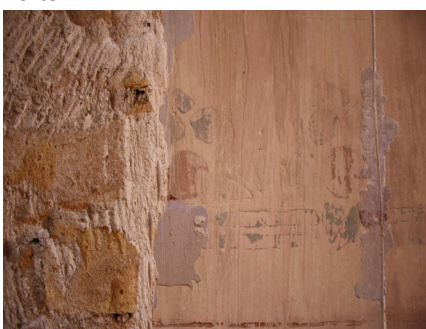
Figura 51. Detalle de pérdidas, película pictórica y otras intervenciones en el muro orientado al norte.
