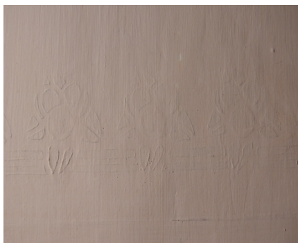
Figura 28. Detalle encalado con relieve de la cenefa.
