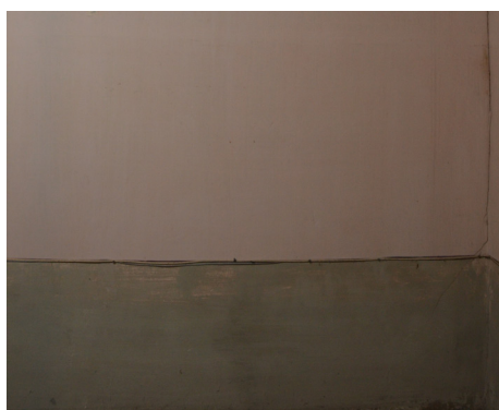
Figura 21. Detalle del zócalo.
