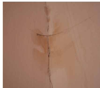
Figura 37. Detalle de suciedad superficial acumulada en la esquina de los muros este-sur.
