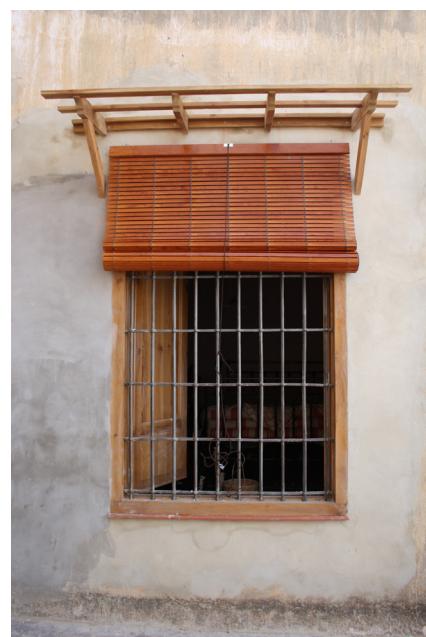
Figura 53. Detalle de otras intervenciones en el muro orientado al norte: vista desde el exterior de la habitación.
