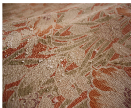
Figura 38. Detalle de las sales desprendidas del techo sobre la cama.
