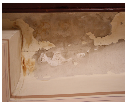
Figura 44. Detalle de las sales presentes en el techo.
