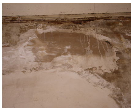
Figura 43. Detalle de las sales presentes en el muro norte.
