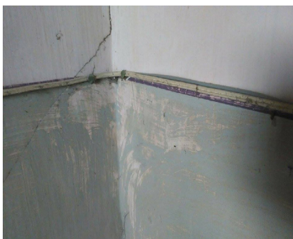
Figura 41. Detalle de suciedad superficial localizada en el zócalo de la esquina sur-oeste.
