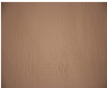
Figura 30. Detalle de zona de encalado con relieve.
