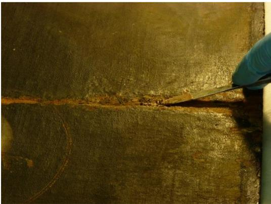
Fig 69. Estucado de faltante en la zona de unión de los paneles.
