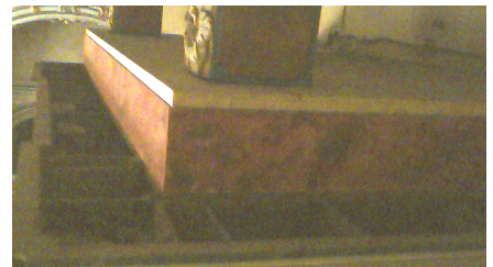
Fig.34 Zona descoberta de les ornamentacions de la zona superior.
