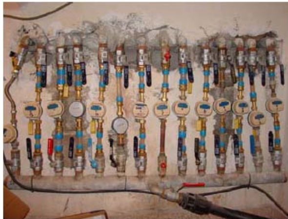
Figura 5.18. Contadores de chorro único instalados en posición vertical (Arregui, et al., 2007)
