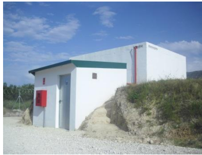
Ilustración 31: Depósito de agua
