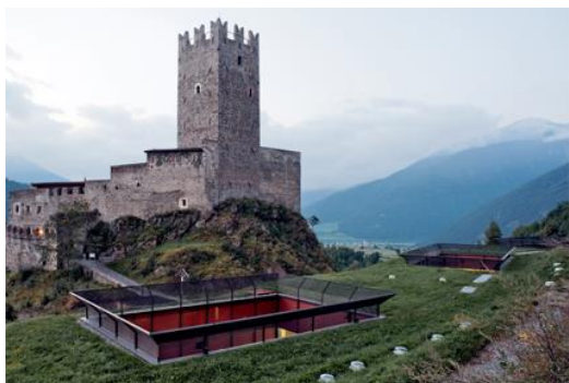
Figura 10. Ampliación Escuela Agrícola
