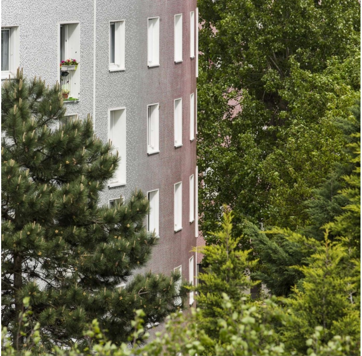
Figura 16. Nueva fachada del edificio de Le Serpentin
