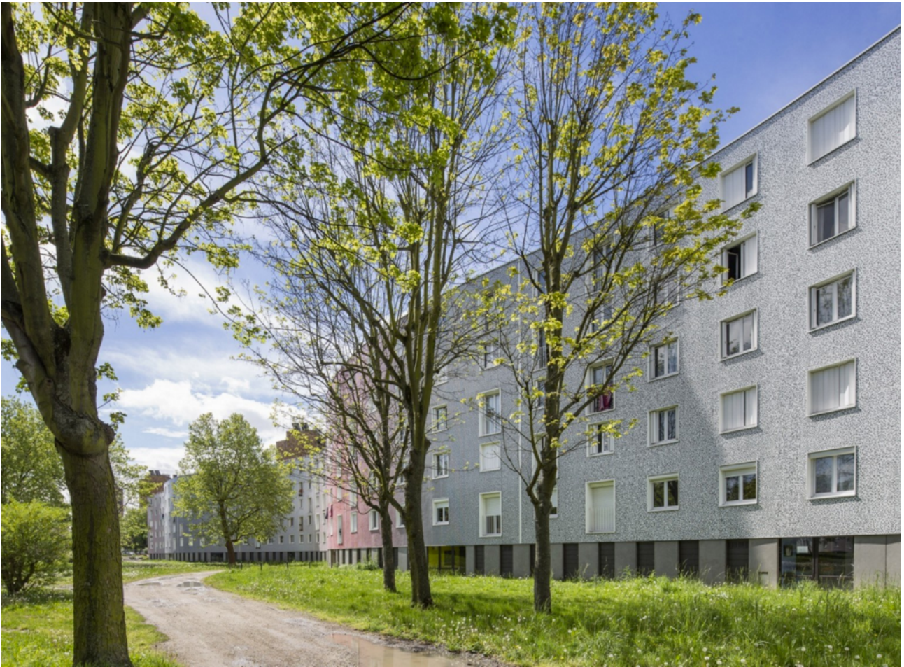
Figura 17. Nueva fachada del edificio de Le Serpentin
