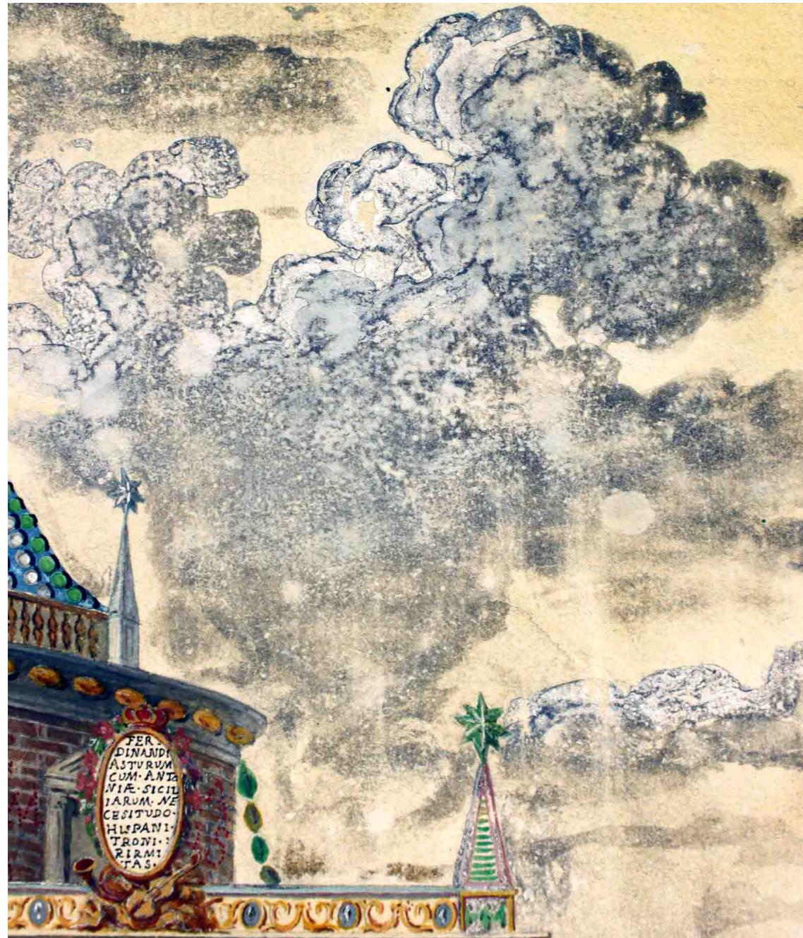
Fig. 65 Pintura anónima de la Basílica de la Virgen. Detalle de la degradación provocada por el albayalde
