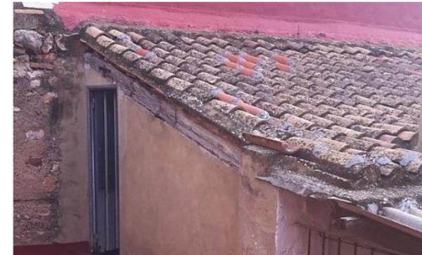
Fotografía 43. Cubierta tipo C5 en zona almacén. Propio autor
