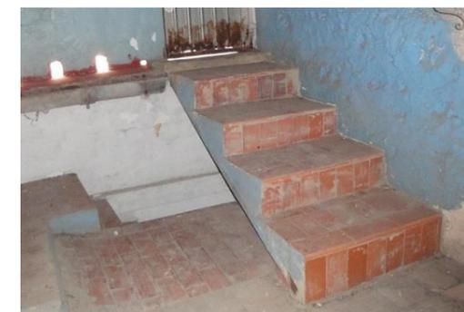
Fotografía 45. Segundo tramo de la escalera en forma de "L" que muere en el primer nivel del edificio y tramo recto que da acceso a la terraza. Propio autor
