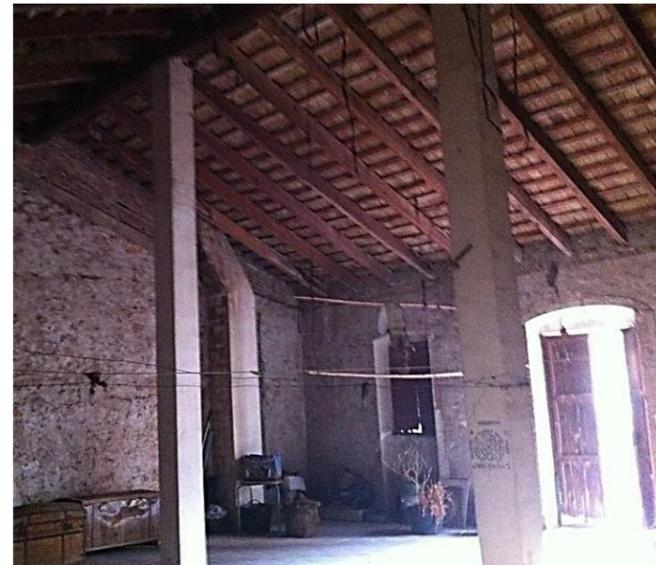
Fotografía 35. Pilar planta primera interior vivienda. Propio autor
