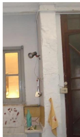
Fotografía 37. Pilar revestido con cal. Propio autor
