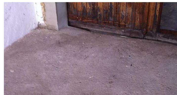
Fotografía 50. Pavimento de solera de hormigón en zona patio y almacén. Propio autor
