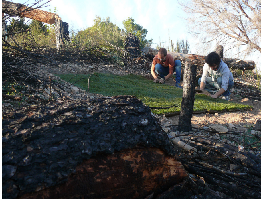
Fig. 26 Proceso de construcción de la intervención.
