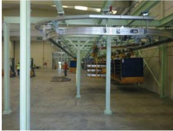
Figura 11. Túnel de Proveedores
