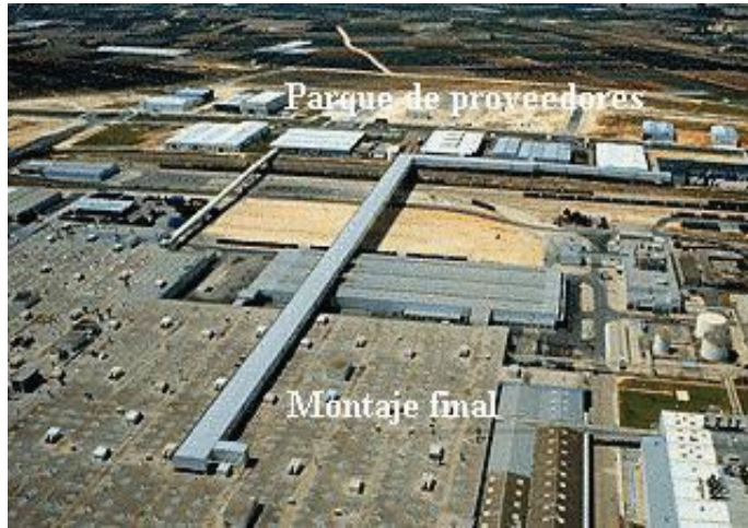
Figura 7. Ubicación parque proveedores y montaje
