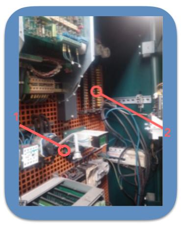
En el punto 1 de la imagen, podemos observar el dispositivo seccionador roto, este elemento es el que obliga a desconectar la tensión para permitir abrir el cuadro eléctrico de forma segura. En el segundo punto, se puede distinguir tres embarrados eléctricos sin ninguna clase de protección.
