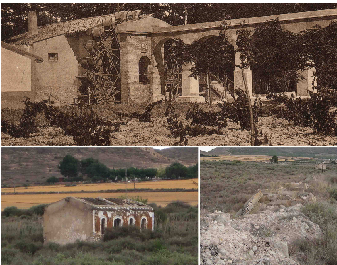
Fig.5.2.1.2. En la imagen superior, conjunto hidráulico en 1915 (tarjeta postal de 1915, propiedad de la autora). En las imágenes inferiores, estado actual de la vivienda y el acueducto (fotografías de la autora, de junio de 2014).
