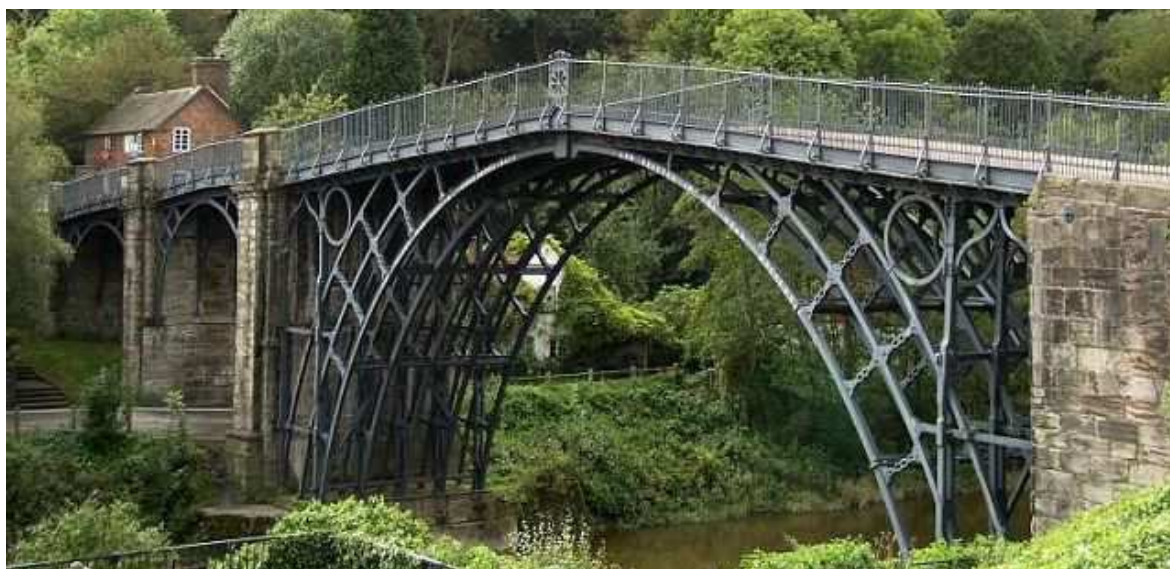
Fig.3.3.1. Imagen del puente Iron Bridge , sobre el río Severn < http://www.arqhys.com/contenidos/fotos/contenidos/coalbrookdale.jpg >.
