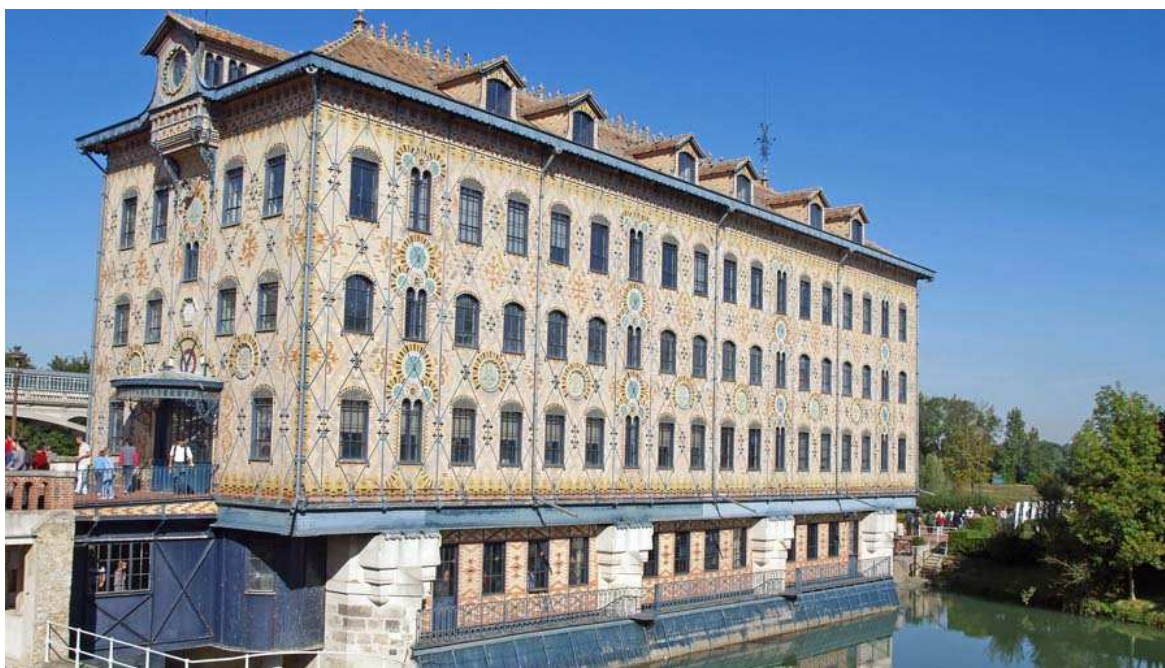
Fig.3.1.2.2. Fábrica de chocolates Menier, de Jules Saulnier, en la ciudad francesa de Noisiel-Sur-Mer. < www.lemoniteur.fr/article/l-usine-menier-a-noisiel-l-architecture-au-service-du-chocolat-14135511 >.
