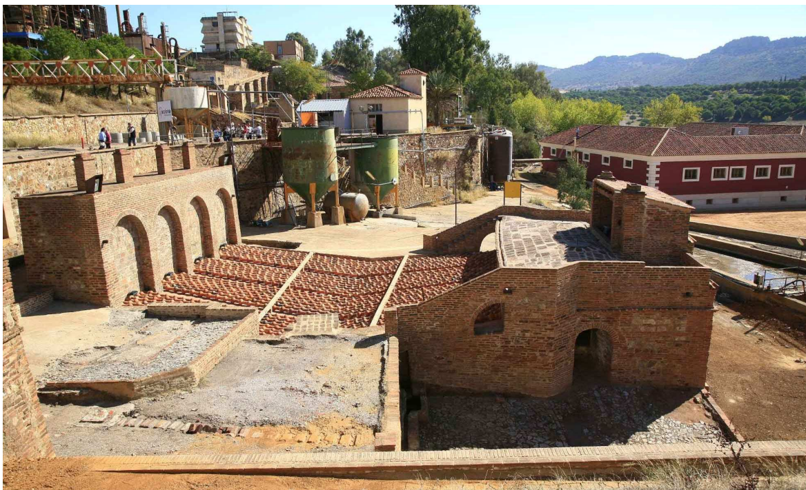
Fig.3.3.1.2. Horno Bustamante o de aludeles de la Mina de Almadén, Ciudad Real. < www.incuna.es >.
