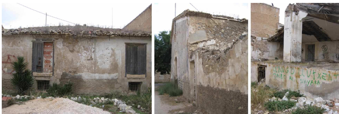
Fig.5.2.5.3. De izquierda a derecha: las puertas elevadas del lagar, el acceso principal y el interior del edificio, en su estado de ruina actual. Fotografías de la autora en octubre de 2012 y junio de 2014.
