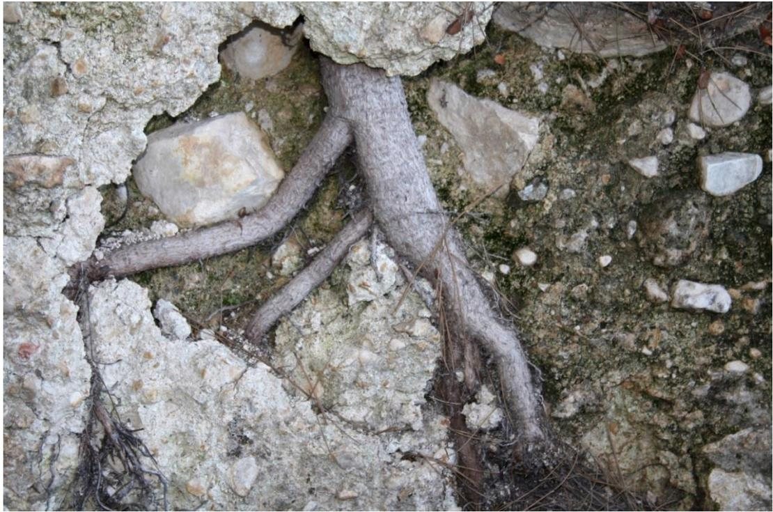
3. Erosión y desprendimiento del enlucido o capa superficial de la estructura, exponiendo, desde hace tiempo, el núcleo de las estructuras a las inclemencias climáticas.
