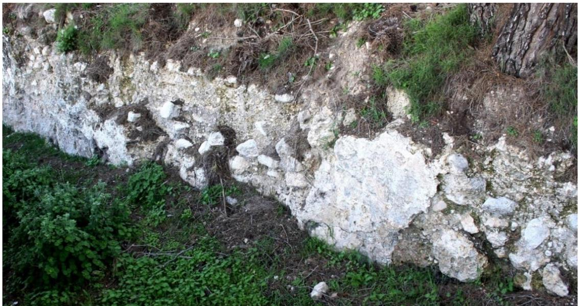
4. Enraizamiento de la flora baja sobre los muros y superficie del aljibe.
