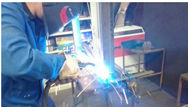
Ilustración 69 Union de los perfiles mediante soldadura MIG/MAG por los alumnos del Campus de Alcoi de la UPV
