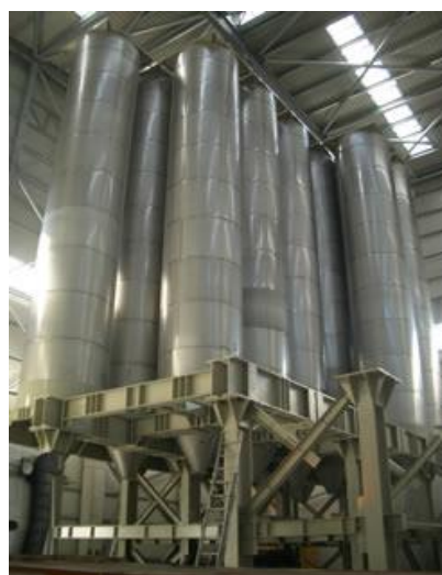
Figura 3.3 Silos de Almacenamiento
