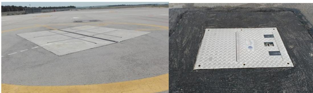
**Figura 9: Puesto de estacionamiento (izquierda) y punto de conexión del puesto (derecha)**
