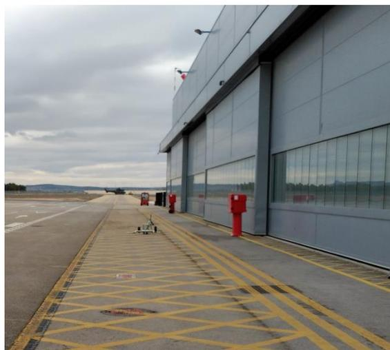
Figura 22: Columnas hidrantes exteriores de color rojo
