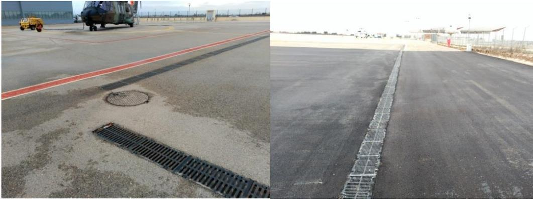
Figura 10: Sumideros de la red de drenaje distribuidos por la plataforma
