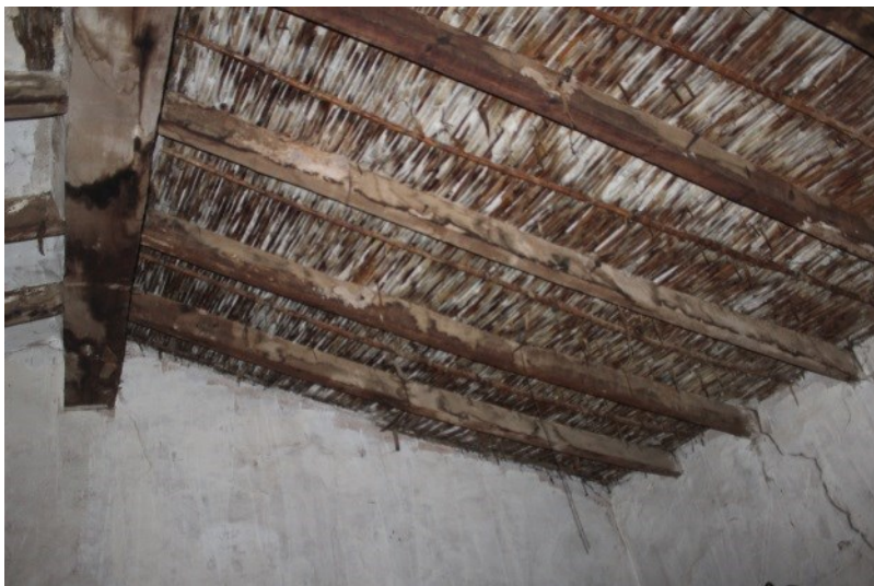
Fotografía 13. Sistema de estructura de cubierta. 2016. Fuentes propias
