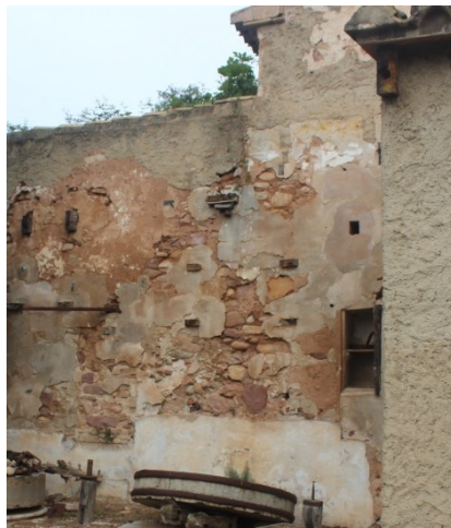
Fotografía 20. Restos estructuras. 2016. Fuentes propias
