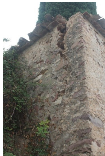
Fotografía 15. Grieta vertical en fachada. 2016. Fuentes propias
