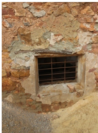
Fotografía 21. Hueco ampliado. 2016. Fuentes propias
