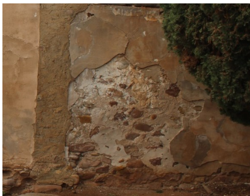
Fotografía 11. Revestimientos en muros. 2016. Fuentes Propias
