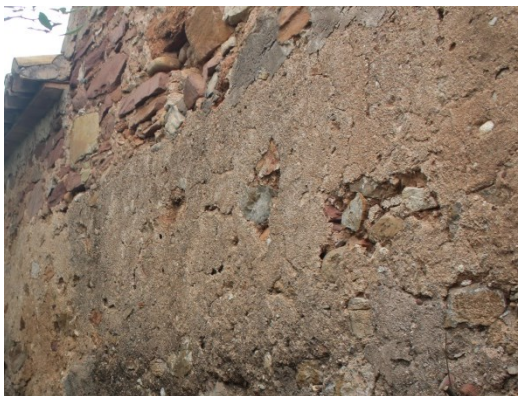
Fotografía 10. Aspecto exterior de los muros. 2016. Fuentes Propias
