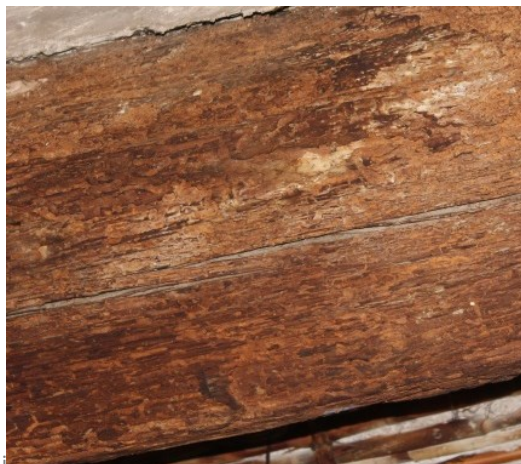
Fotografía 27. Detalle viga. 2016. Fuentes propias
