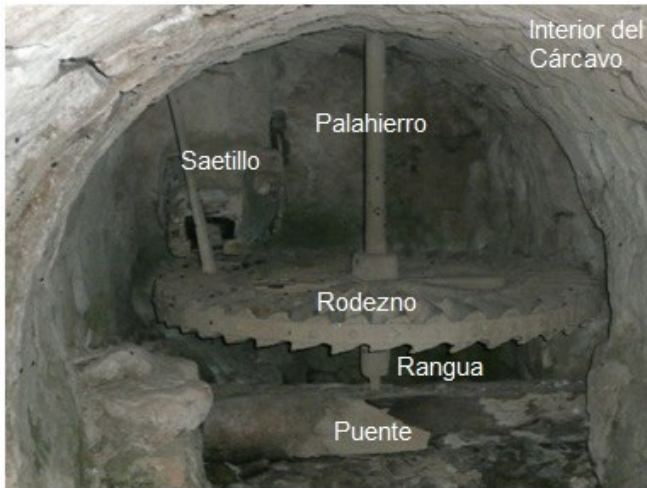
Fotografía 1. Interior cárcavo Molino de las Ánimas en Santiago Pontones (Jaén). 2012. Lorena Ros
