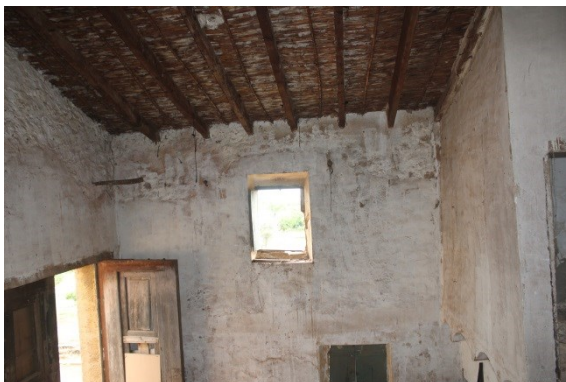
Fotografía 12. Aspecto interior de los muros. 2016. Fuentes Propias
