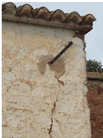
Fotografía 15. Grieta vertical en fachada. 2016. Fuentes propias
