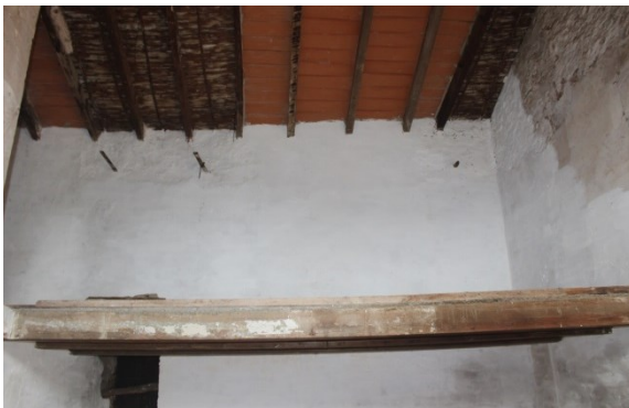
Fotografía 7. Tramo de cubierta y forjado reconstruido. 2016. Fuentes propias.
