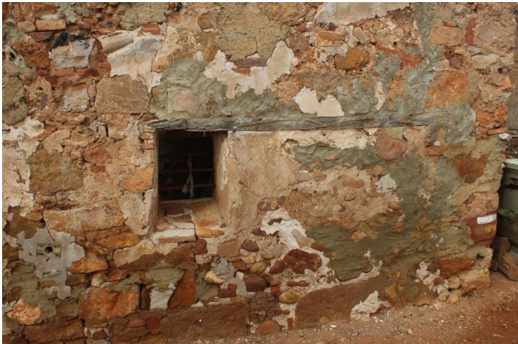
Fotografía 23. Reducción de hueco bajo dintel. 2016. Fuentes propias
