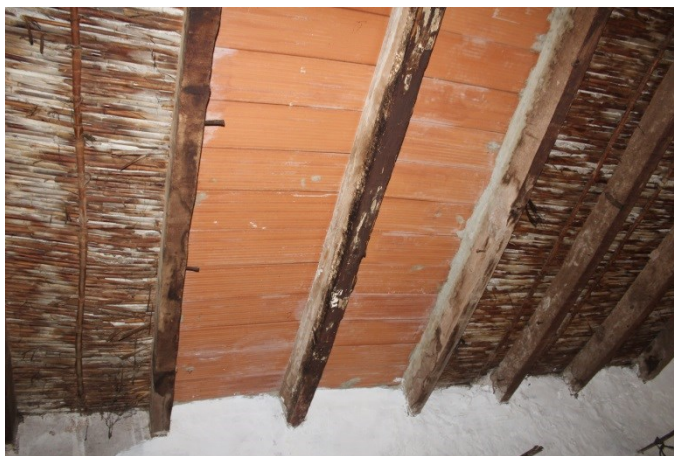
Fotografía 33. Materiales faldón cubierta. 2016. Fuentes propias
