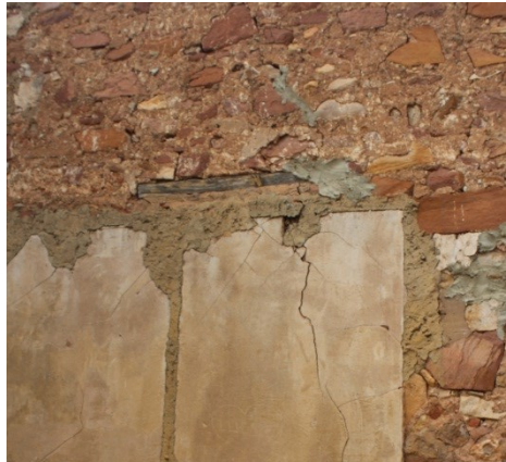
Fotografía 22. Reformas bajo un antiguo dintel. 2016. Fuentes propias
