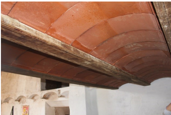
Fotografía 6. Reposición de forjado. 2016. Fuentes propias
