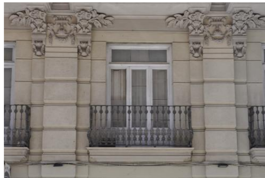
Imagen 78. Fachada principal balcones de planta 1º
