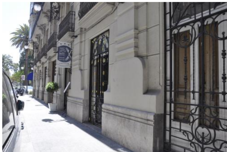
Imagen 77 Fachada principal entrada a local comercial
