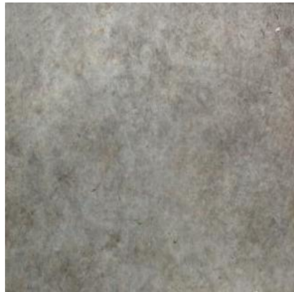
Acabado de hormigón fratasado Uso: Solado en zona media de cafetería
