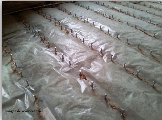
Detalle de colocación plástico + anclajes (Pr.01)
