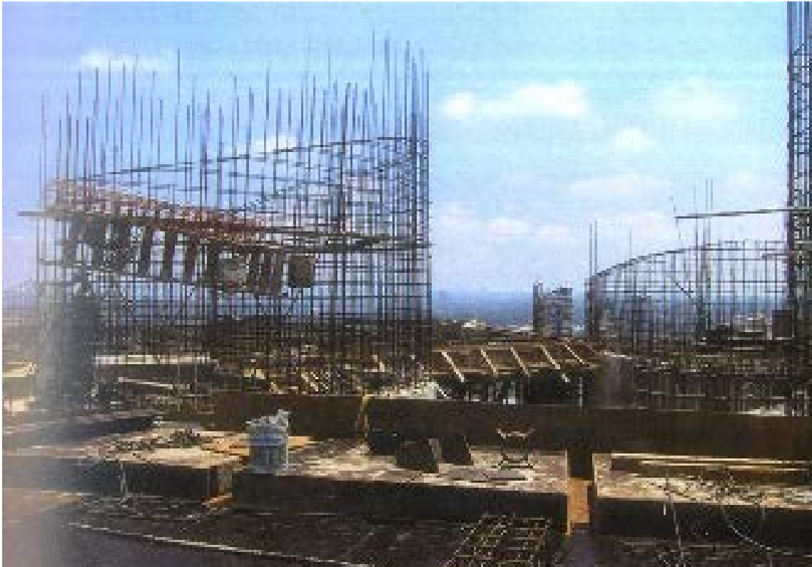
Imagen 38. Fotografía del armado de los muros curvos de hormigón. Documentos de Arquitectura nº 60. Revista del Colegio de Arquitectos de Almería.
