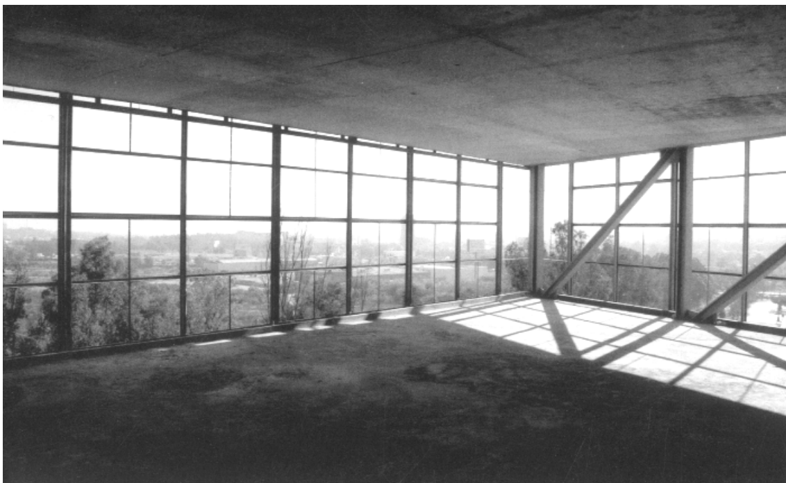
Imagen 33. Fotografía de la viga celosía (derecha). Documentos de Arquitectura nº 60. Revista del Colegio de Arquitectos de Almería.
