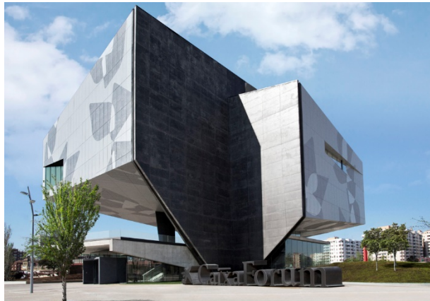
Imagen 16. CaixaForum de Zaragoza. Carme Pinós Arquitecturas. Daniela Colafranceschi.
