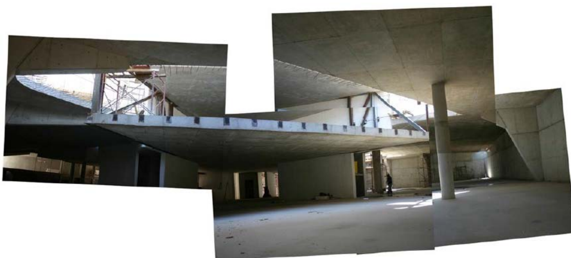
Imagen 32. Foto montaje del encuentro de la primera planta de oficinas con el sótano del edificio. Documentos de Arquitectura nº 60. Revista del Colegio de Arquitectos de Almería.
