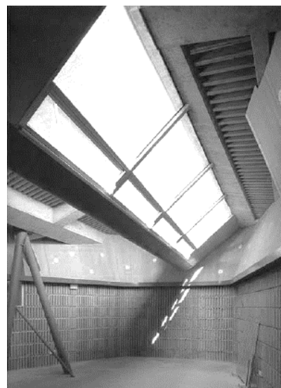
Imagen 5. Lucernarios generados a partir de los vuelos de las viseras de hormigón. El Croquis nº 49/50. Enric Miralles y Carme Pinós
