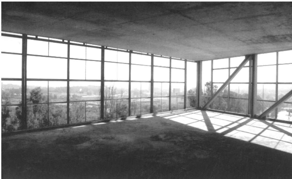
Imagen 47. Fotografía de la viga celosía (derecha). Documentos de Arquitectura nº 60. Revista del Colegio de Arquitectos de Almería.
