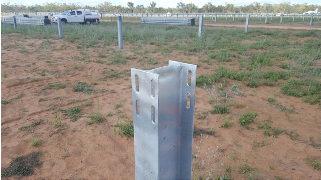
Figura 3.9: Perfil galvanizado hincado para la estructura con seguidor de Barcaldine, Australia.
