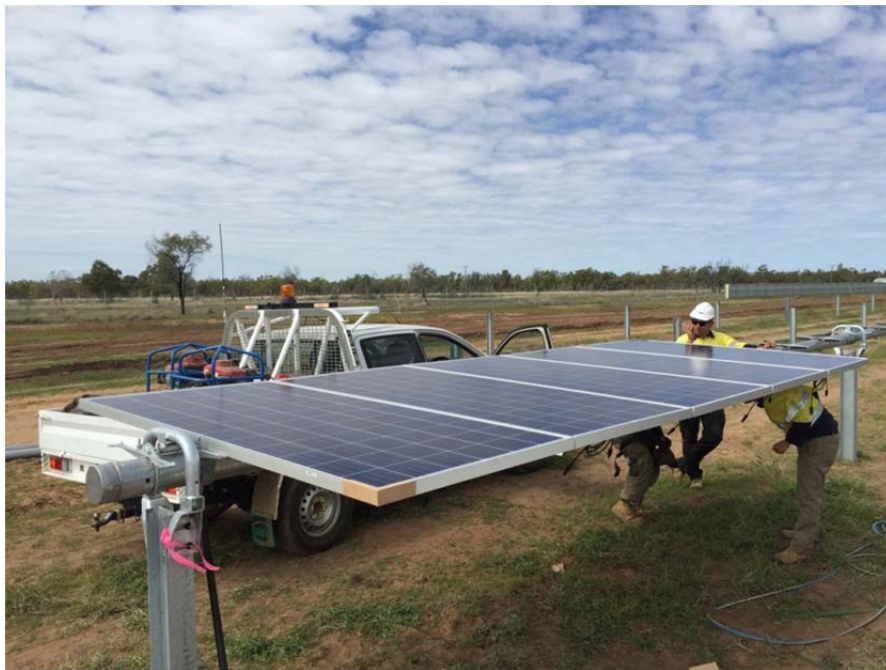
Figura 2.3 Módulos fotovoltaicos sobre estructura con seguidor (NEXTracker). Fuente: Construcción del parque solar de Barcaldine, Australia. Elecnor 2016
