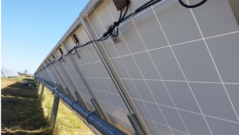
Figura 4.18: Conexionado de los módulos a tresbolillo en Barcaldine Solar Farm Fuente: Fotos de archivo de Barcaldine Solar Farm
