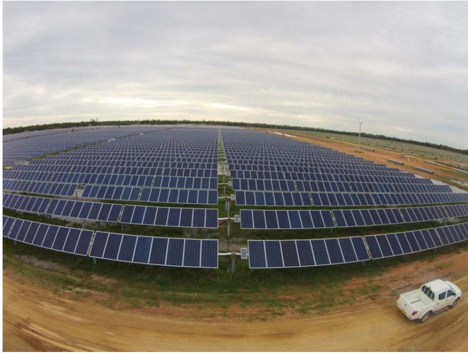
Figura 3.10: Estructura de NEXTracker montada en Barcaldine, Australia.
