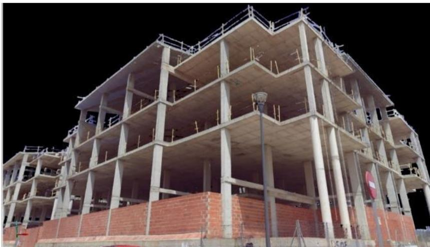
*Fig. 31. Escaneado de la estructura abandonada con escáner laser 3D Topcon FARO 130X. Fuente: Elaboración propia*
