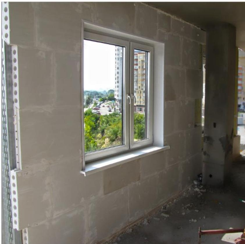
*Fig. 44. Vista desde el interior. Panel SPANS con trasdosado interior por medio de paneles de yeso machihembrados. Fuente: Elaboración Propia.*
