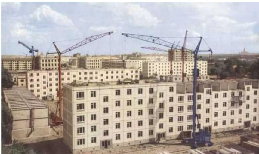
*Fig. 1. Construcción de un edificio de viviendas de la serie K-7. Fuente: <http://76-82.livejournal.com/3837677.html> Fecha de consulta: 12.02.2016*
