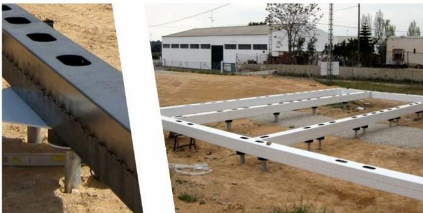
*Fig. 27. Cimentación por pilotes enroscados. Fuente: <http://barcelonahousingsystems.com/technology/>. Fecha de consulta: 12.10.2016*
