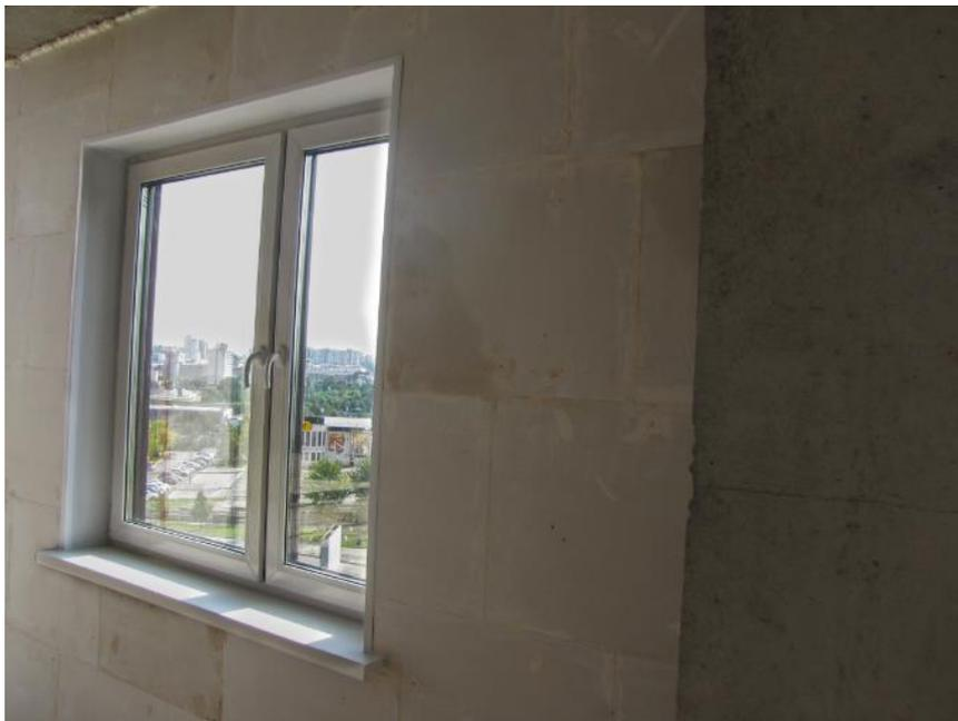
*Fig. 45. Vista desde el interior. Panel SPANS con trasdosado interior por medio de paneles de yeso machihembrados. Fuente: Elaboración Propia*
