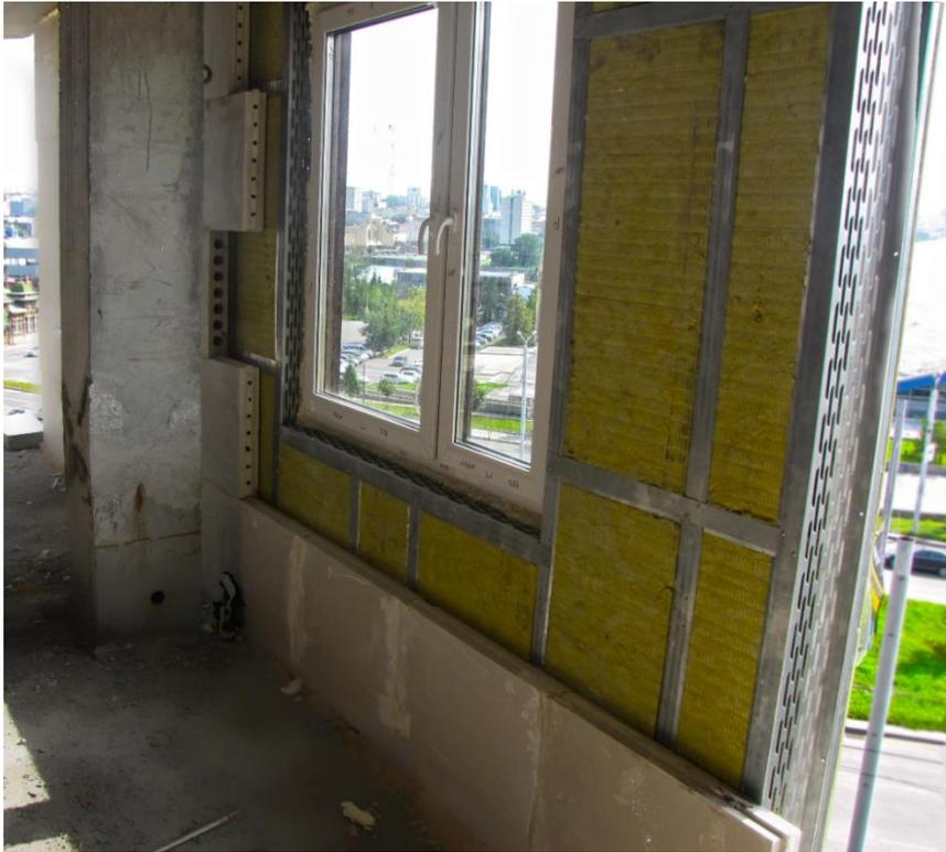
*Fig. 50. Vista posterior del proceso de trasdosado del panel SPANS. Fuente: Elaboración propia.*
