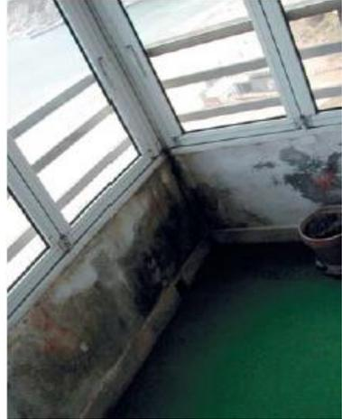
*Fig. 65. Efectos de una condensación en zona de un puente térmico. Fuente: Guía del estándar passivhaus. Fenercom. 2011*
