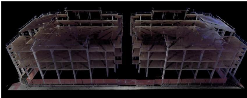
*Fig. 32. Escaneado de la estructura abandonada con escáner laser 3D Topcon 130X. Fuente: Elaboración propia*
