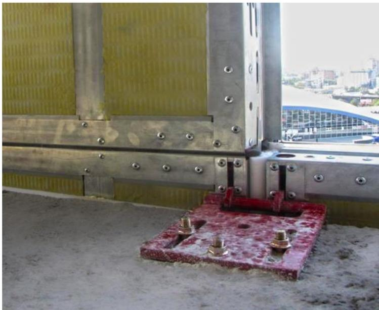
*Fig. 40. Instalación de los paneles SPANS en una obra. Fuente: Elaboración propia.*
