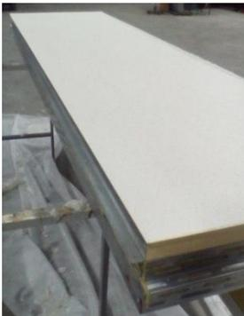
*Fig. 84. Aplicación del monocapa sobre la cara exterior de un panel en plano horizontal. Fuente: Elaboración propia.*
