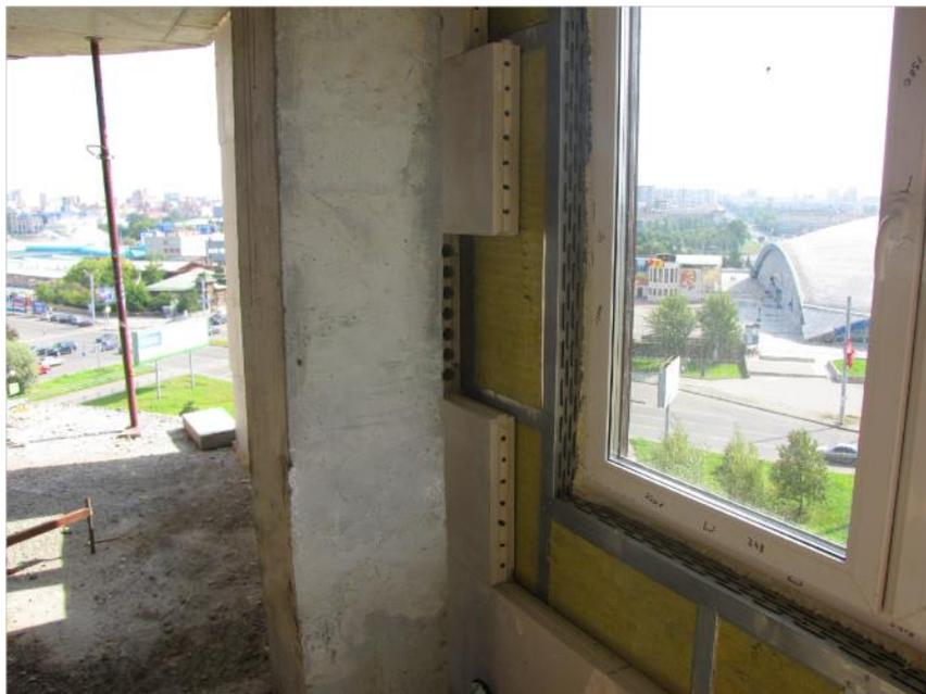
*Fig. 43. Instalación de los paneles SPANS. Proceso de trasdosado. Fuente: Elaboración propia.*
