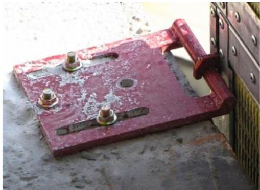
*Fig. 70. Imagen del sistema de anclaje NOK v04 puesto en obra.
