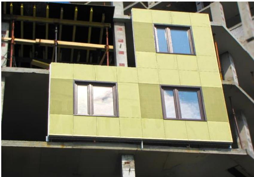
*Fig. 46. Paneles SPANS instalados como una demostración de la tecnología en Chelyabinsk, Rusia. 2014. Fuente: elaboración propia.*
